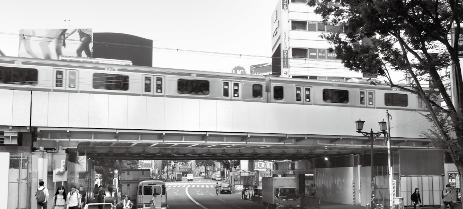
宮益架道橋架替 (埼京線上り線) 2018年度土木学会 田中賞
