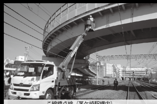
ご線橋点検 (茅ヶ崎駅構内)
