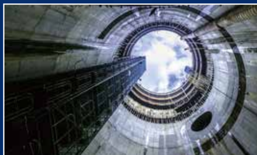
●福岡市下水道中部2号幹線立坑
