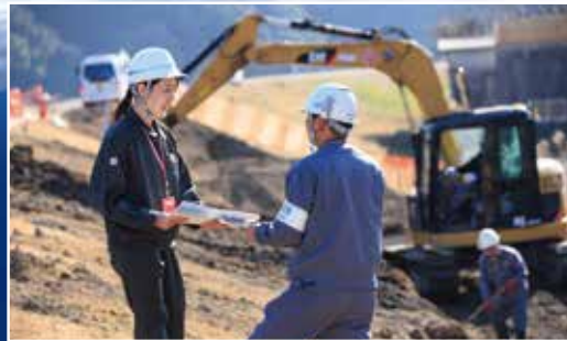
●大淀川堤防補強工事に従事する土木技術者
