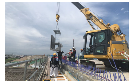
写真-5 吊込み状況
