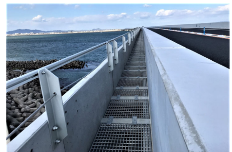
写真-3 PCa 側溝完成
