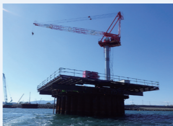
作業構台とタワークレーン
