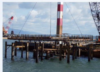
導枠の一括架設
