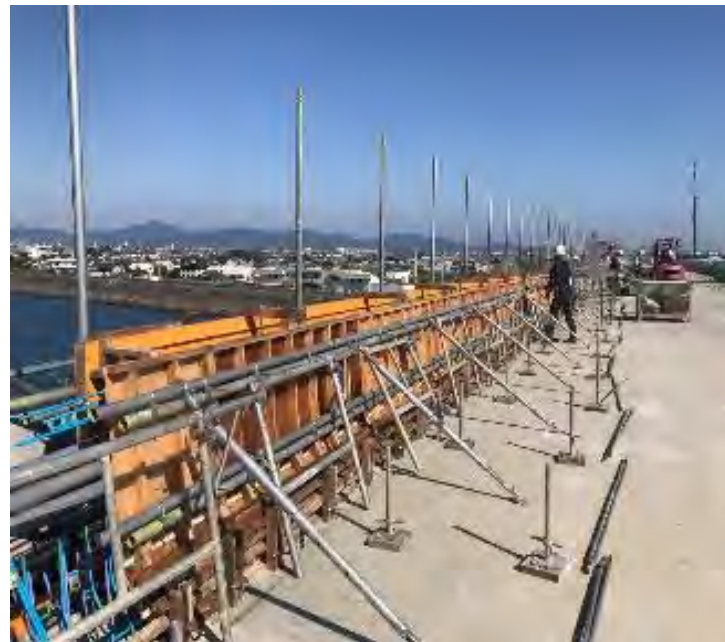
壁高欄型枠組立
