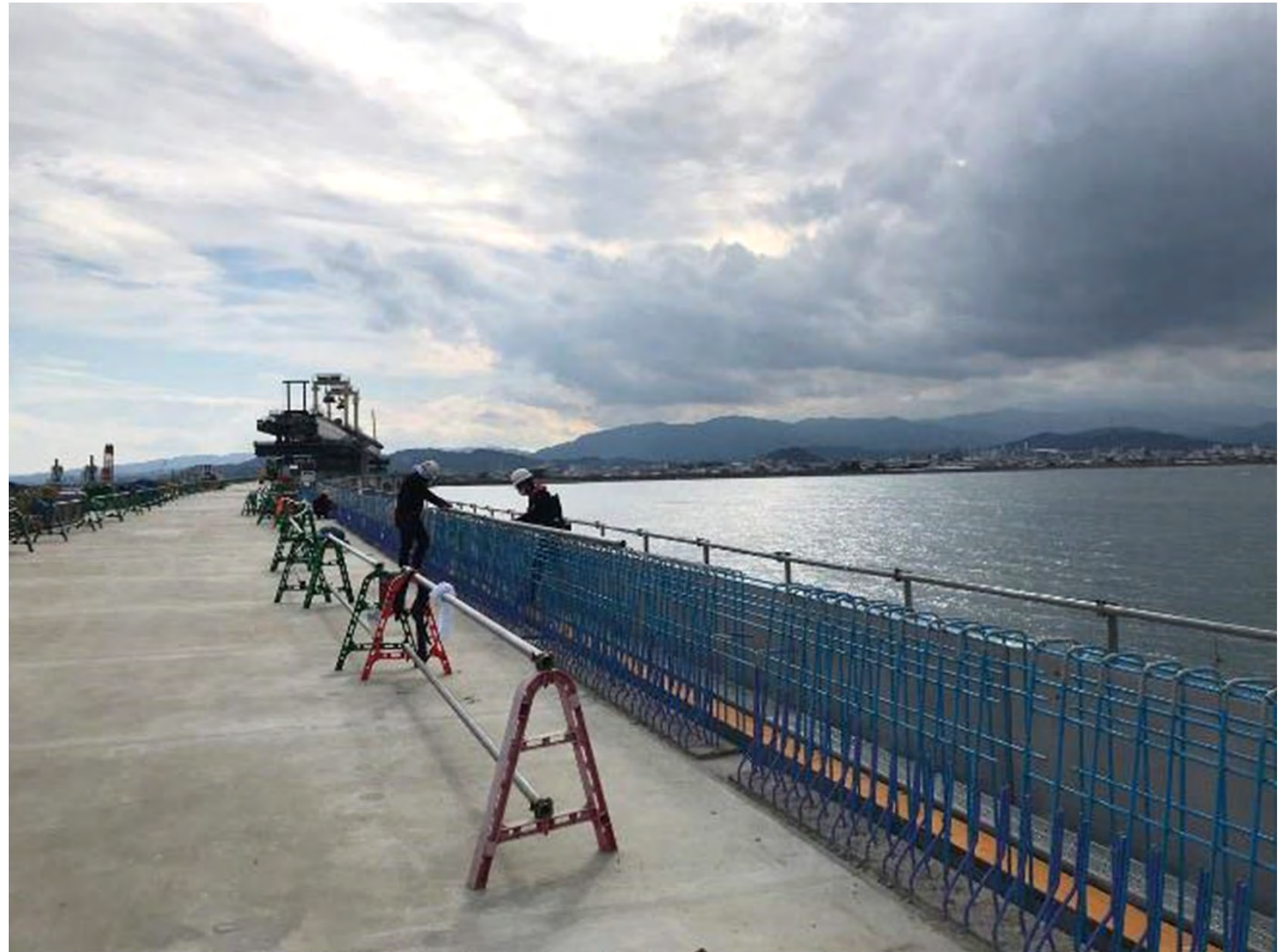
壁高欄鉄筋組立
