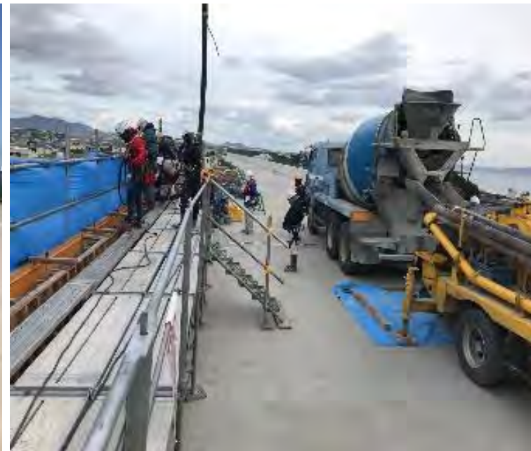
コンクリート打設
