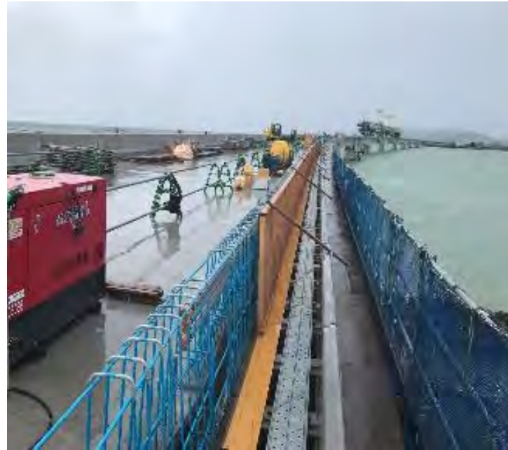
壁高欄型枠組立
