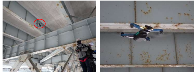
写真-3 ドローン (Skydio2) による点検状況
