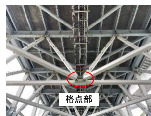
写真-1 点検困難部位
