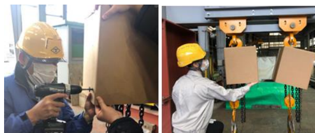
図10 防音装置の取付状況
