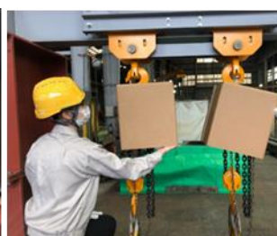
図11 施工性確認状況
