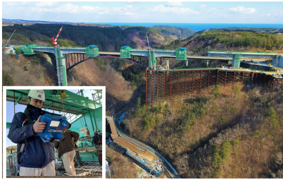
写真6 検査状況（新思惟大橋上部工工事）
