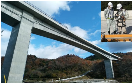
写真5 検査状況（東根川橋上部工工事）
