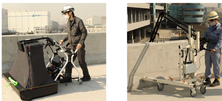
図4 ひび割れ検知ロボットによる撮影状況
