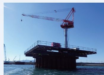
作業構台とタワークレーン
