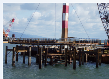
導枠の一括架設
