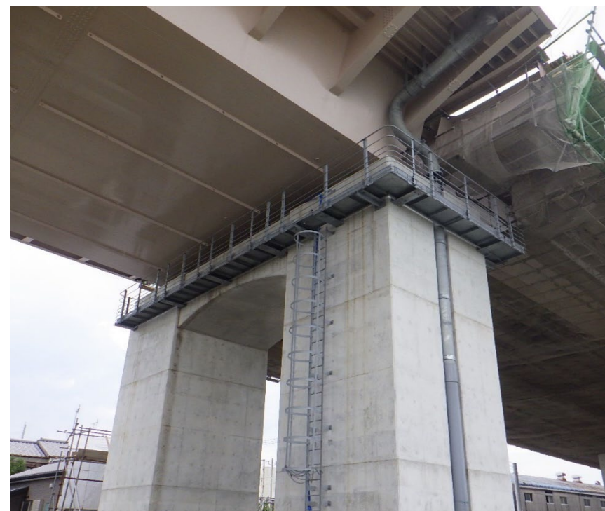
【下部工検査路】
