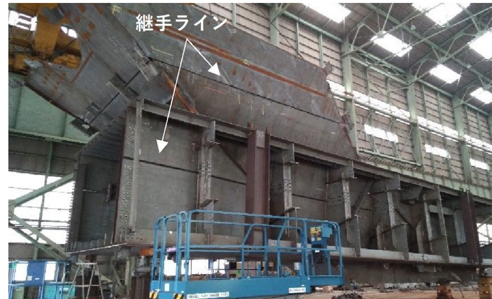
【隅角部組み立て状況】
