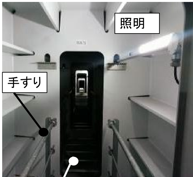
ステップ 【アーチリブ内部】
