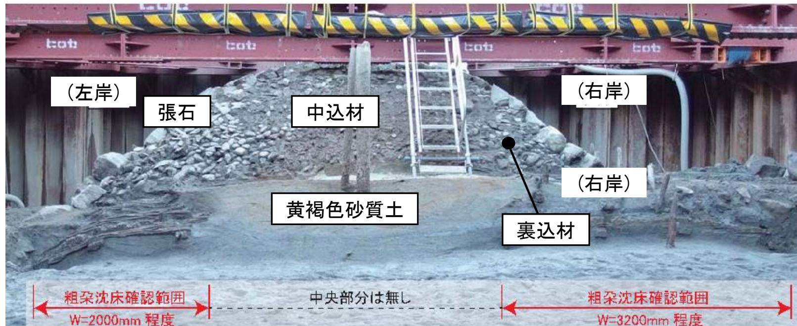
【デ・レイケ導流堤の解体調査状況】
