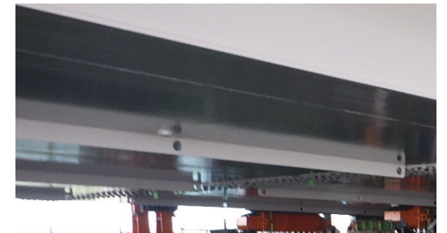
【吊金具(補剛桁下面)】
