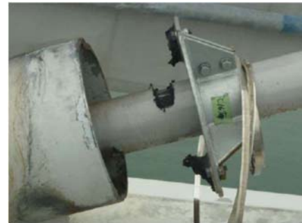
制振ゴムが破断して本体が損傷
