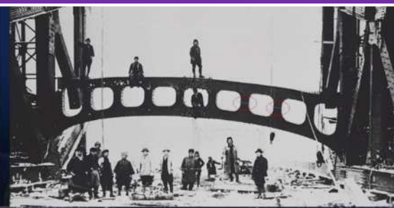
橋門構築時 一部に溶接が使われている(昭和6年11月)
