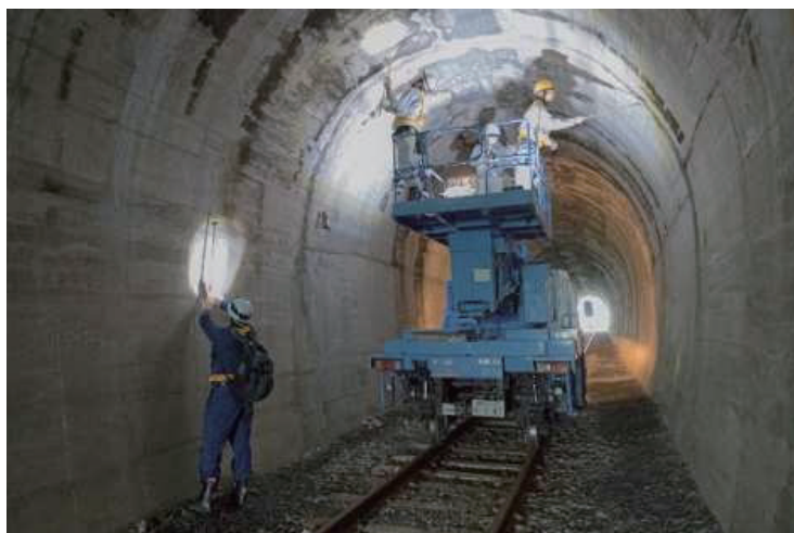
トンネルの検査状況
