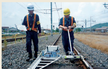
軌道の検査状況
