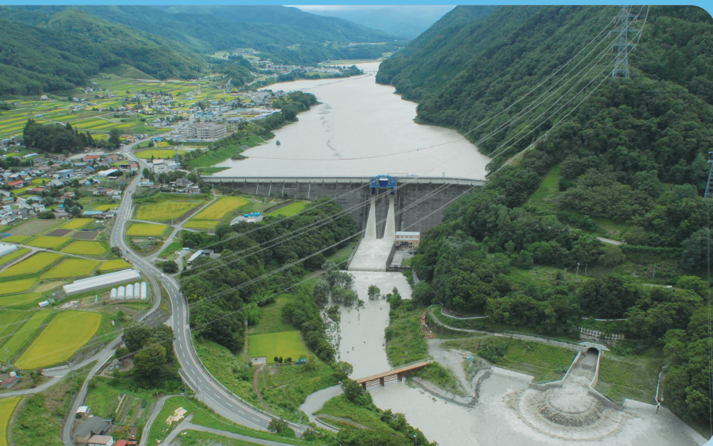
美和ダム（1958年竣工）、 土砂バイパストンネル （2005年竣工）
