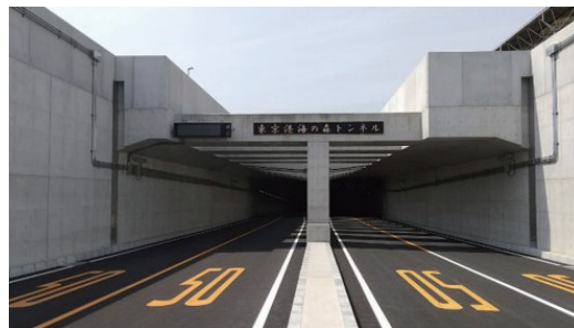
東京港海の森トンネル（トンネル）
