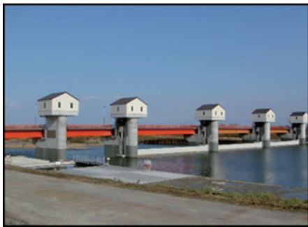
写真 河川から農業用水を取水する頭首工（取水堰）
