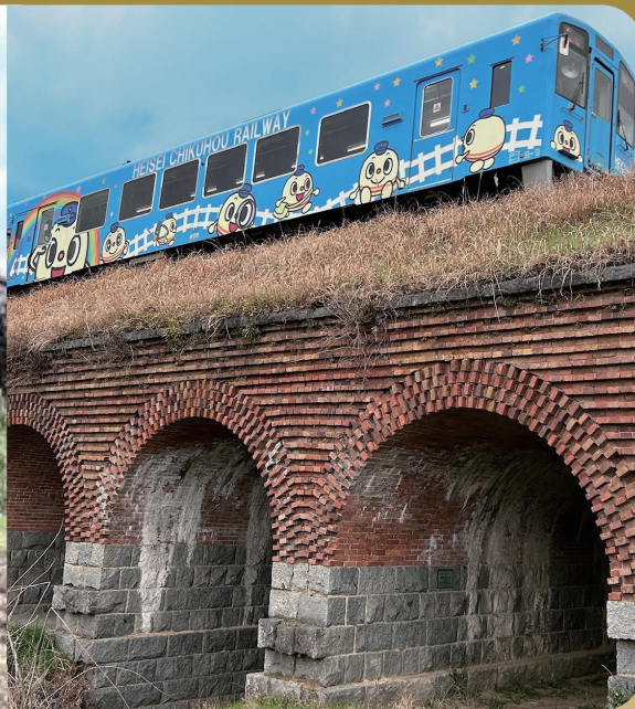
平成筑豊鉄道 内田三連橋梁 煉瓦造 3 連アーチ橋 1895 年、経年 129 年 筑豊地方の運炭鉄道網拡充のために 設立された豊州鉄道株式会社が油須原 ―香春間に建設した橋長 17 m の煉瓦 造 3 連アーチ橋
