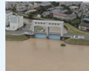
洪水時の水門。本川の水位が高くなった際に、水門を閉鎖することで、本川の洪水を支川に逆流させないようにしています。
