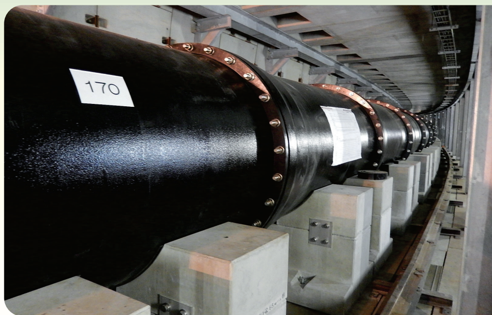
御堂筋共同溝内に設置された水道管路 提供：大阪市水道局
