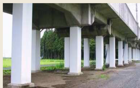
鋼板巻きによる高架橋の耐震補強
