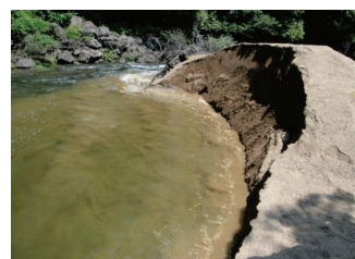
全国の 30 以上のダムで、掘削した土砂を下流河川に供給する土砂還元（または置き土）が行われています。
