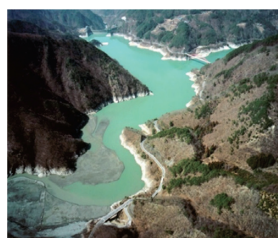
ダム貯水池の堆砂の状況。貯水池上流部において堆砂が生じていることが確認できます。貯水容量を確保するため定期的な維持掘削を実施しております。
