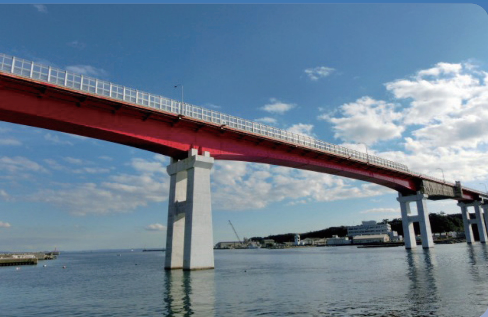
城ヶ島大橋 (神奈川県三浦市・令和5年度土木遺産)
