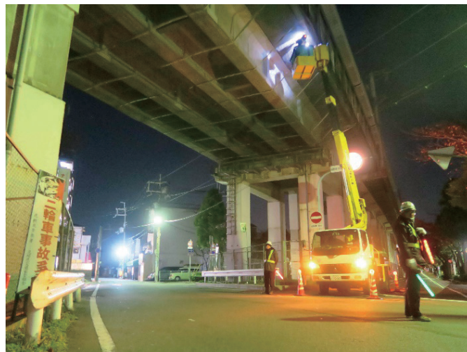
橋梁の検査状況
