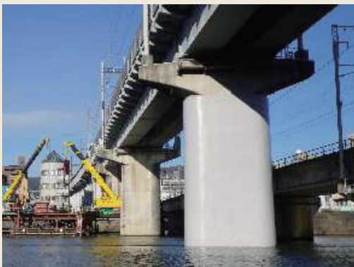
橋脚の耐震補強
