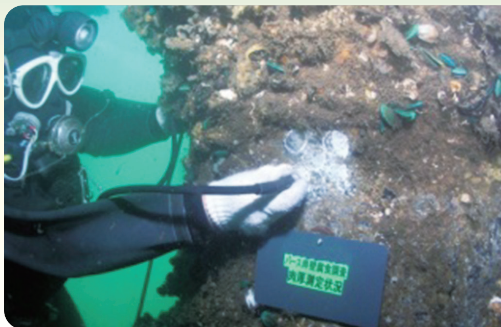
栈橋（鋼管杭）の点検状況
