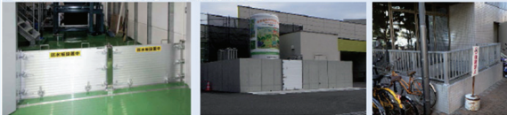
脱着式防水板 建屋外設備周囲の防水壁 ドライエリアの高上げ
