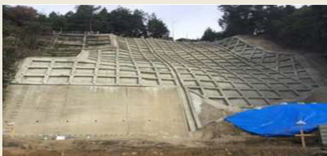
コンクリート枠による斜面の補強
