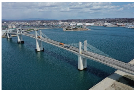
小名浜マリブリッジ（橋梁）
