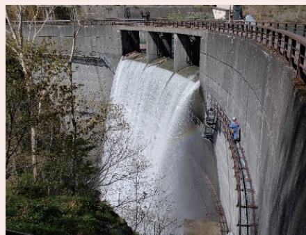
コンクリートダムの表面劣化の点検作業
