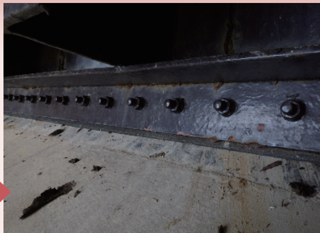
洪水吐ゲートの背面側。老朽化に伴い、表面部分に錆が発生している場合は、計画的に補修しています。
