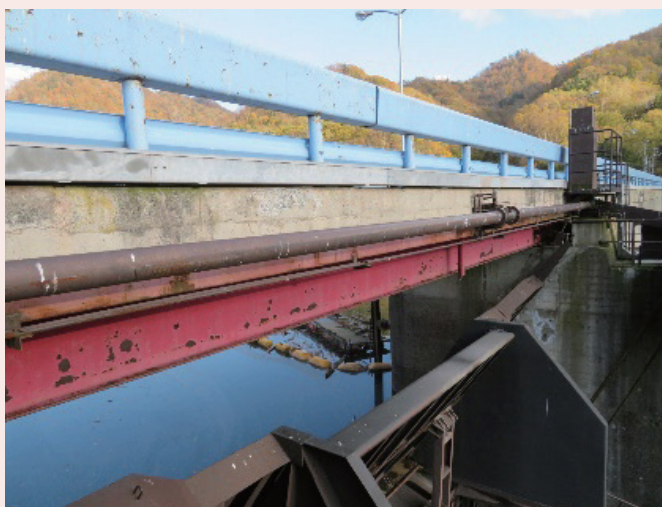
ダム天端にある通路橋やゲート開閉装置（巻上機）。老朽化に伴い、表面部分などに錆が発生している場合は、計画的に補修しています。
