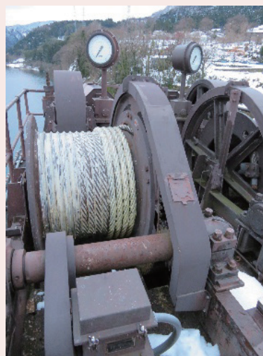
ダム天端にある通路橋やゲート開閉装置（巻上機）。老朽化に伴い、表面部分などに錆が発生している場合は、計画的に補修しています。
