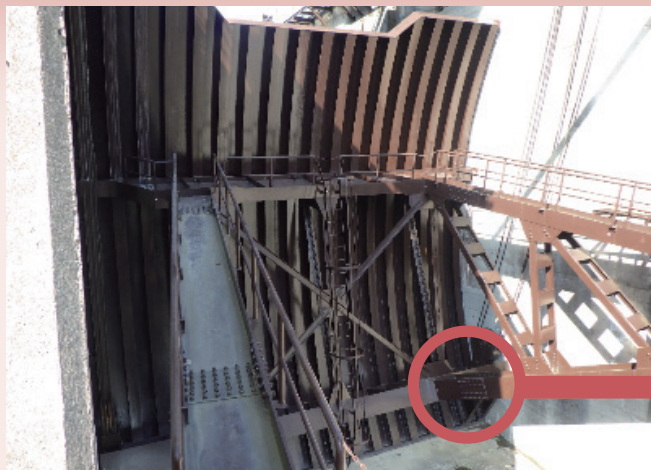
洪水吐ゲートの背面側。老朽化に伴い、表面部分に錆が発生している場合は、計画的に補修しています。
