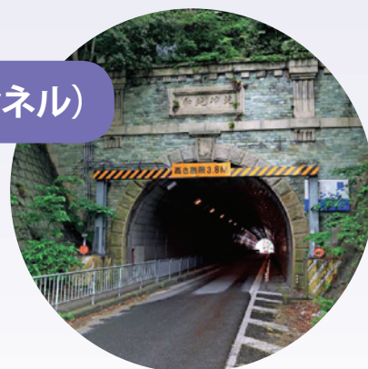
鵬雲洞・毛見隧道
