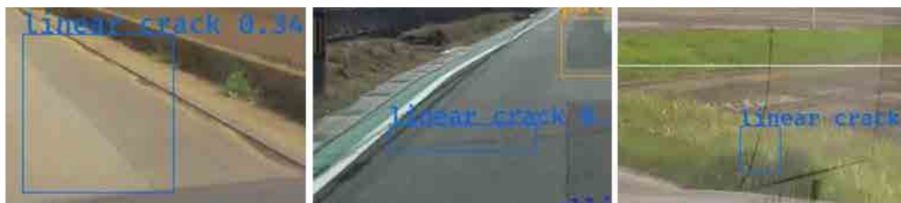
図 2.3.5 線状ひび割れの誤検出の例
