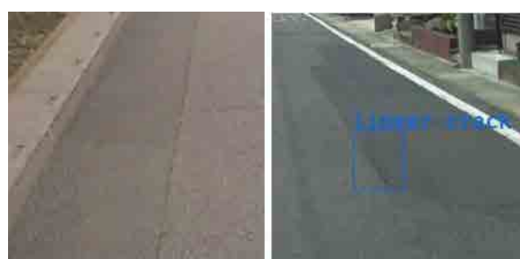
図 2.3.6 パッチングの検出漏れの例
