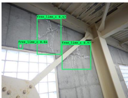
図 5.2.11 遊離石灰 c の検出例 (YOLO v3)
