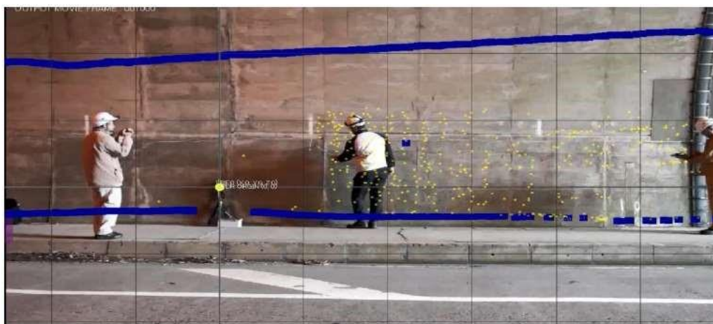
図 4.2.6 ハンマー打撃の AR 提示
