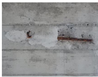
図 5.2.2 鉄筋露出
