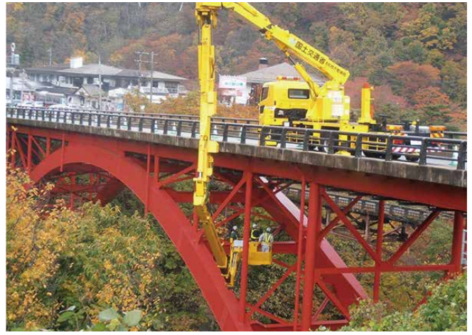
図-2 上路式アーチ橋の点検 4)
