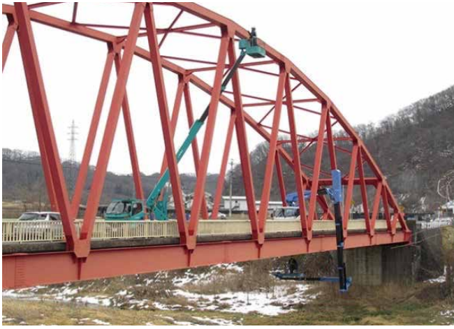
図-1 下路式トラスランガー橋の点検 4)
