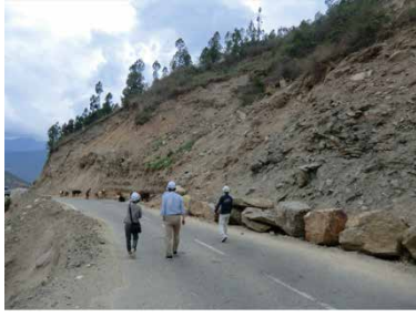
図-1 ブータン 国道1号線の斜面崩壊
