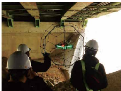
図-2 橋梁下部工への球殻ドローンの実証実験
