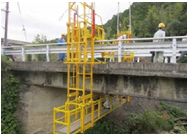
図-2 異なる自治体でも類似のニーズ:簡易点検足場の実証例(左:近畿フォーラム、右:愛媛大学)
