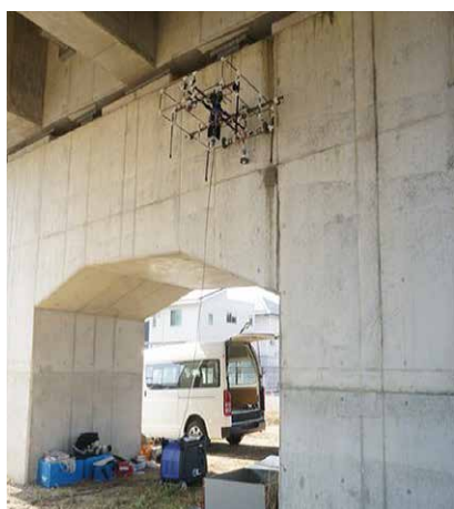
図-8 橋脚側面の点検状況
