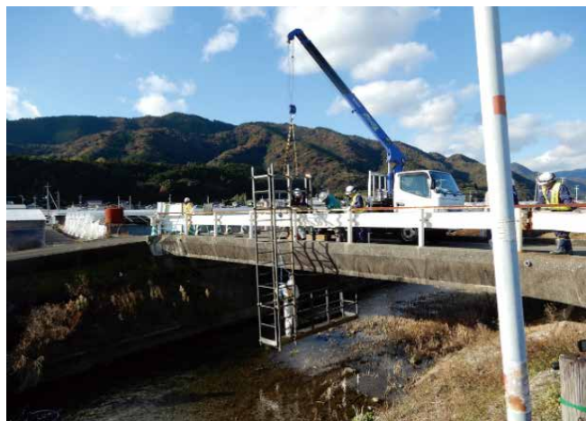
図-2 異なる自治体でも類似のニーズ:簡易点検足場の実証例(左:近畿フォーラム、右:愛媛大学)
