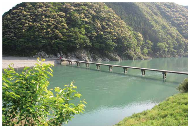
図-1 岩間沈下橋の座屈前の様子
