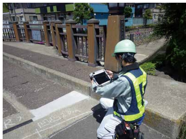
図-5 タブレット端末による橋梁点検風景
