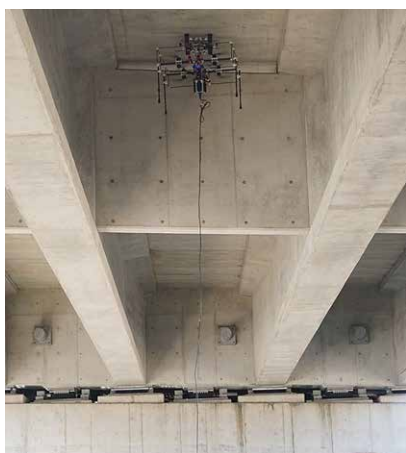
図-7 床版の点検状況
