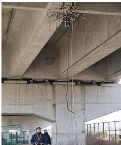
図-6 桁下面の点検状況
