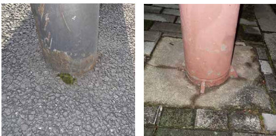
図-1 照明柱・標識柱の基部の埋め込み部の状態
