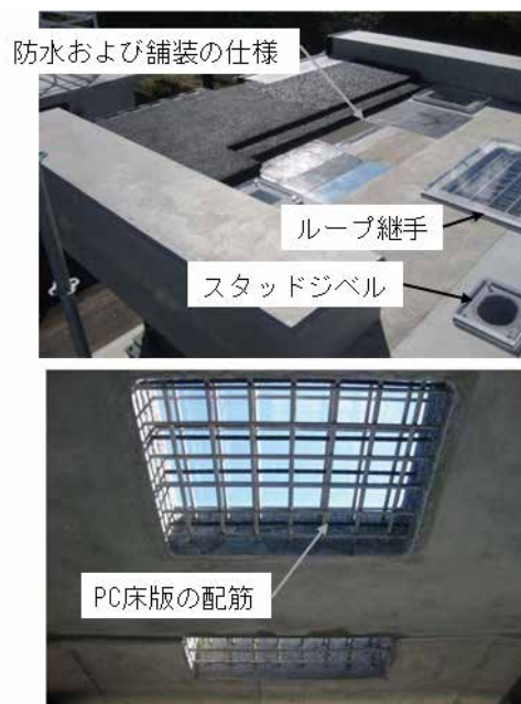
図-6 床版の構造を学ぶモデル (上:舗装構造、下:RC、PC床版の配筋)
