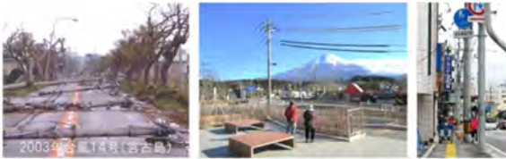
2003年台風14号(宮古島) 災害時に悪影響を及ぼし、景観を破壊し、生活の妨げとなるインフラの例 http://www.mlit.go.jp/road/road/traffic/chicyuka/
