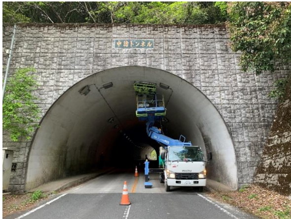
県道646号 中詰トンネル
