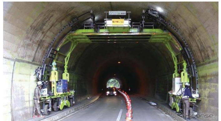
平沢トンネルでの実証実験
