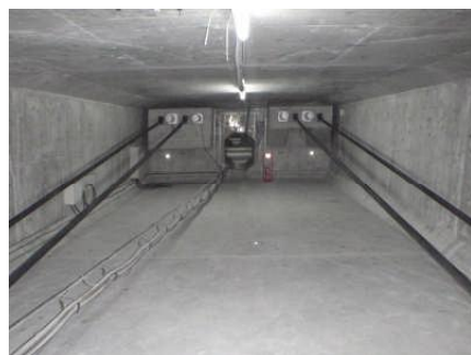
写6.1 箱桁内面の状況
