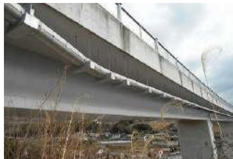
写6.2 箱桁外面の状況
