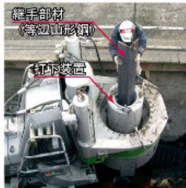
図 継手部材の施工状況
