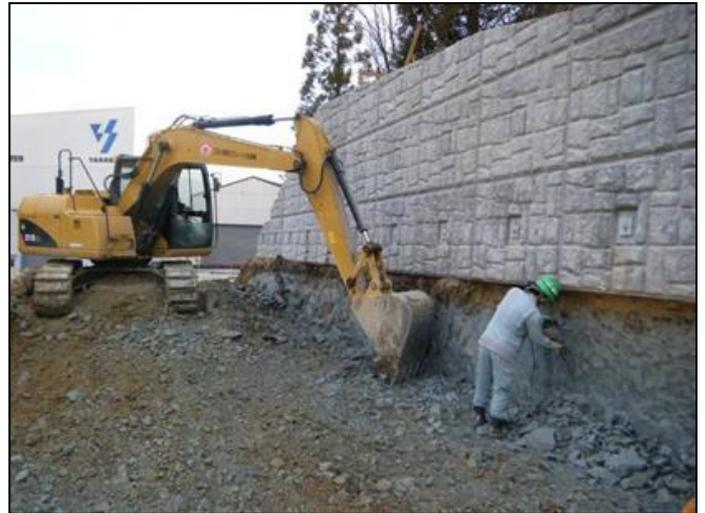
写真-3 逆巻き掘削状況
