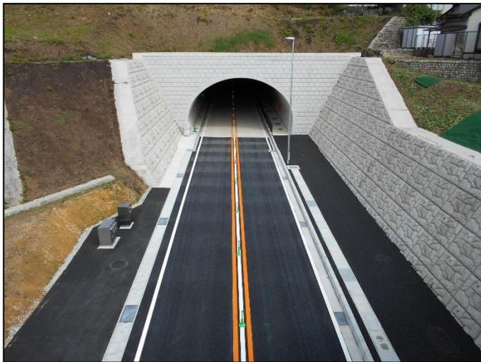
写真-2 PAN WALL 工法施工例
