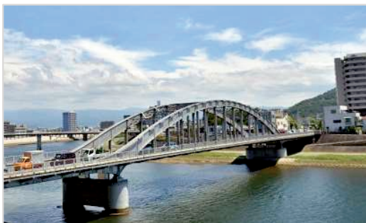
静岡県沼津市 御成橋
