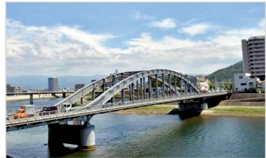
静岡県沼津市 御成橋
