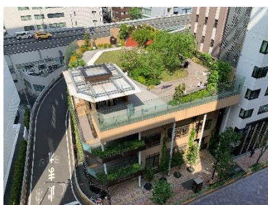
写真 2-2 立体都市公園の例 (東京都中央区) 11
