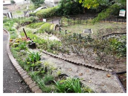
写真 5-3 下水道と公園の連携 (神奈川県横浜市) 66
