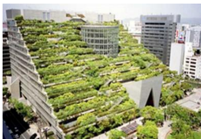
写真 2-8 屋上緑化の例 (福岡県福岡市) 24
