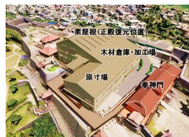
正殿復元に向けた仮設施設の整備
