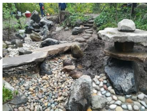
整備後（流れに石橋、滝口、植栽を整備）
