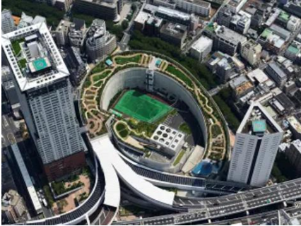
写真 5-1 道路と公園の連携 (東京都目黒区) 64
