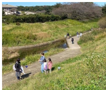
清瀬金山調節池 (東京都清瀬市)
