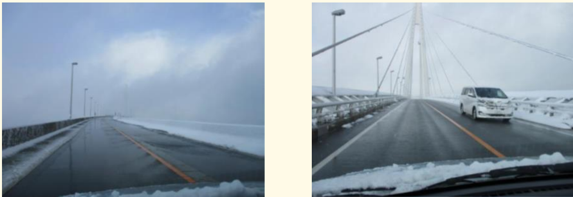
図 13 新湊大橋における下水処理水を利用した消雪(左)、融雪(右) 25
