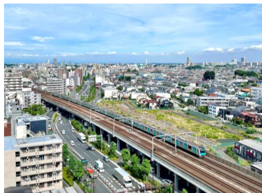
写真 鉄道と道路の立体交差化
