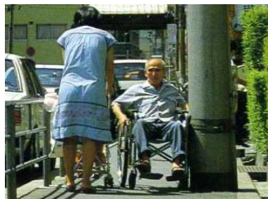
図 2-1-7 電柱が歩行空間を狭め、歩行阻害となっている例 28)
