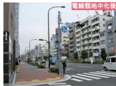
図 2-1-8 電線類地中化後の道路景観 29)
