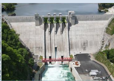
ハッ場ダム (令和 2 年完成)
