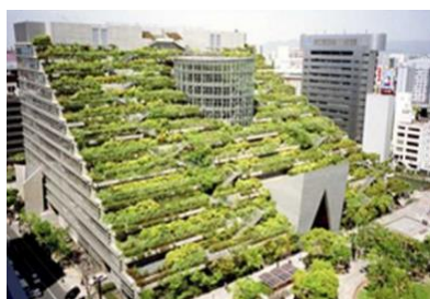
写真 2-8 屋上緑化の例 (福岡県福岡市) 24
