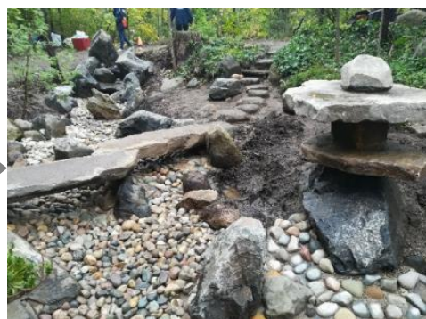
整備後（流れに石橋、滝口、植栽を整備）
