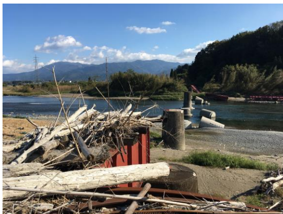
流失した球磨川第四橋梁
