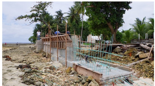
図-2 建設中の垂直護岸
