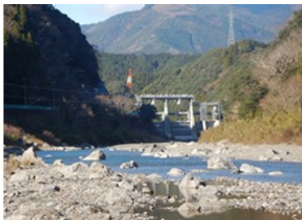
通砂運用のために改造された耳川の西郷ダム．
