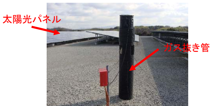
ガス抜き管の位置を考慮したパネル設置
