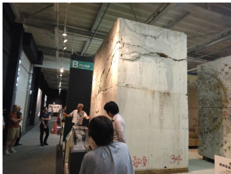
写真②-2 RC 橋脚のせん断損傷 (神戸学習ツアー, 2024)
