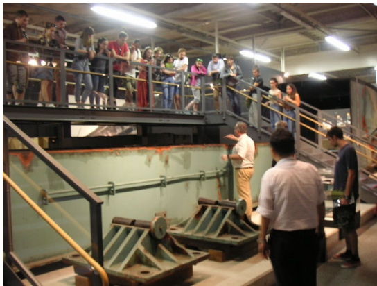
写真②-1 箱桁中間支点部の変形（神戸学習ツアー, 2019）
