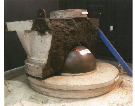
写真②-5 ピボット支承の破損※3)
