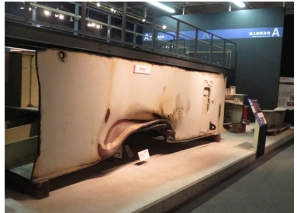
写真②-3 端横桁の変形※2)
