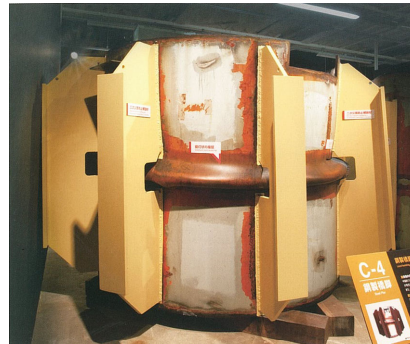
写真②-4 鋼製橋脚の局部座屈 ・破断われ※3)
