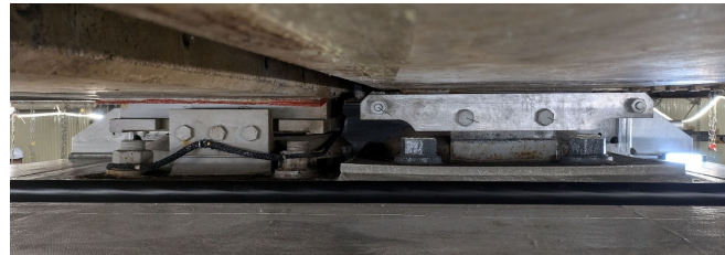
設置完了後（右側）
