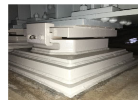
新設支承の設置後
