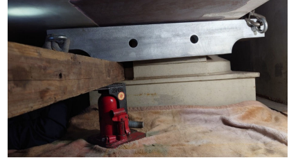
補強ブロックの設置
