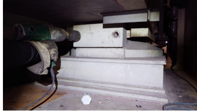
既設サイドブロックの撤去
