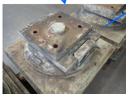
耐震補強でBP-A支承を撤去
