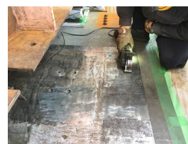
撤去後の仕上げ
