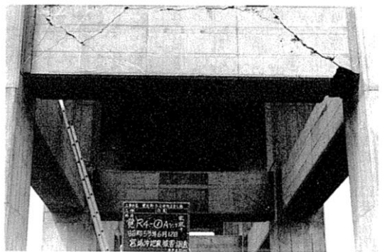
写真2-2-1 中層ばりのひびわれ
