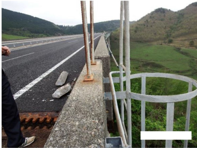
橋梁形式：支間長400m、鋼4径間連続鈑桁及び鋼4径間連続トラス橋 ピンローラー支承
