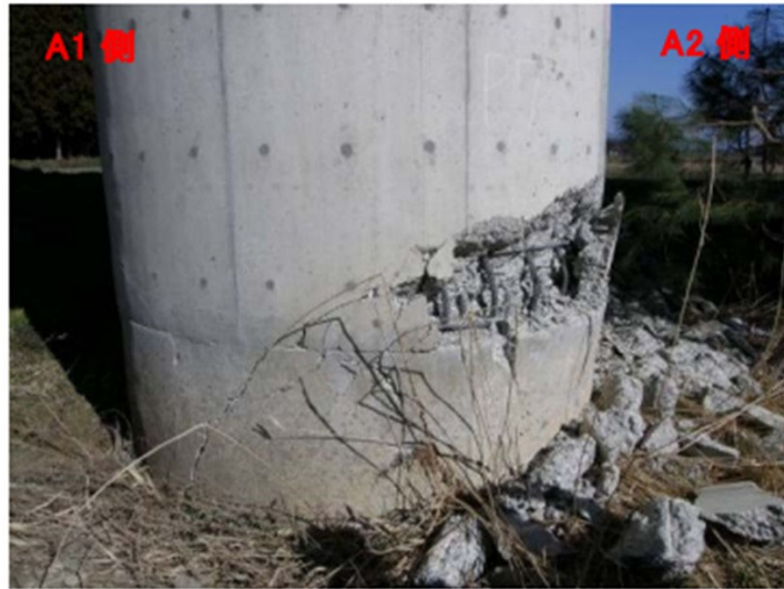
橋梁形式：支間長40m、鋼鈑桁橋、線支承
