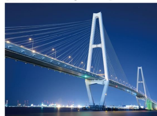
c. 名港中央大橋 (伊勢湾岸道路)
