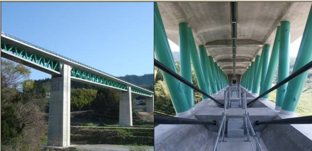
主桁の高さが変化する変断面構造を採用した PC 5径間連続複合トラス橋 中国地方整備局 島根県
