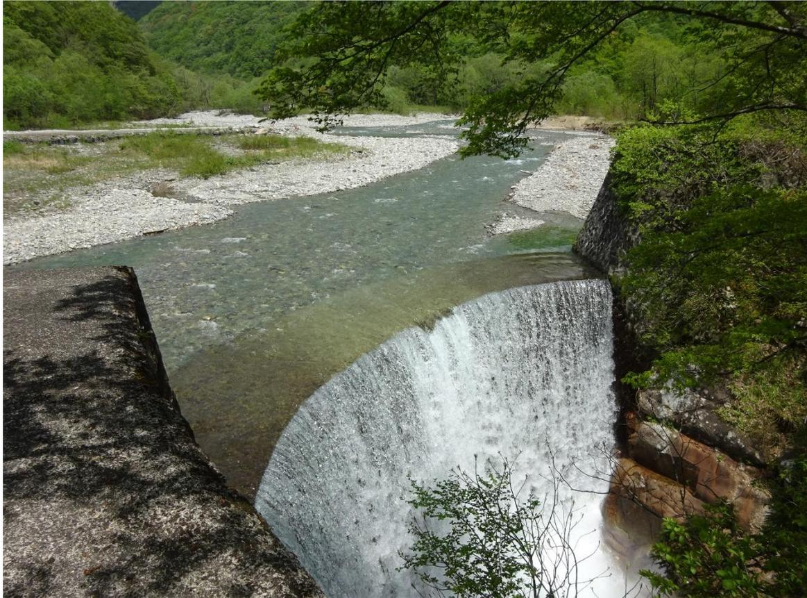
土合砂防堰堤は、湯桧曾川に建設された群馬県初のアーチ式堰堤で、砂防を目的として谷川岳と一体となって景観を形成する貴重な土木遺産です。
