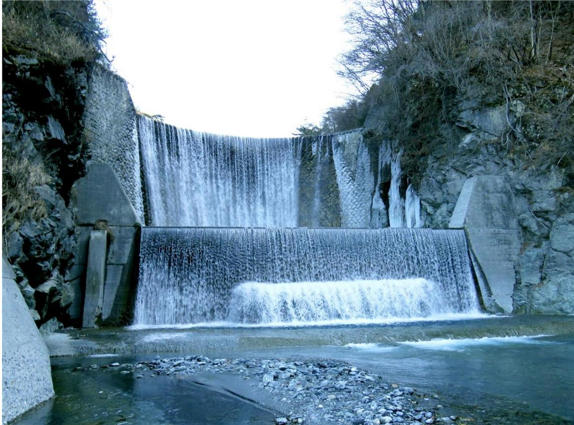
上蔵砂防堰堤は、戦後に花崗岩切石の丁寧な練石積みにコンクリートを充填して全て人力で造られた大規模なアーチダム本堤とその副ダムの砂防施設です。
