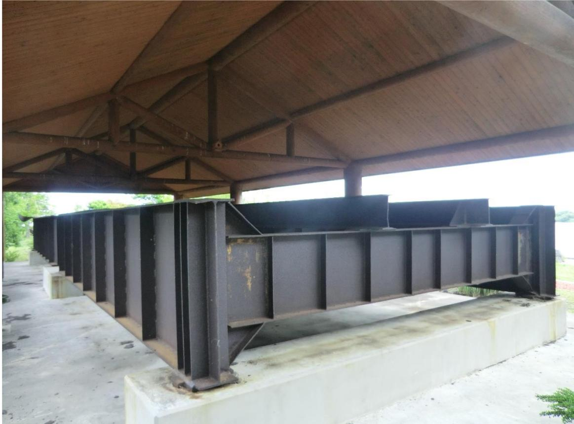
旧運河橋は、鋼材の節約や軽量化、美観の向上を目標に新技術導入に挑んだ先人の気概を示す北海道で最古、国内でも最初期の全溶接単純鋼鈹桁橋です。
