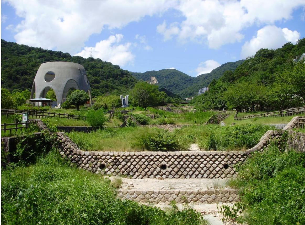
逆瀬川の砂防設備は、赤木正雄によるわが国で最初の流路工の事例であり、その後の補修においても当初のデザインをよく踏襲した優れた土木遺産です。
