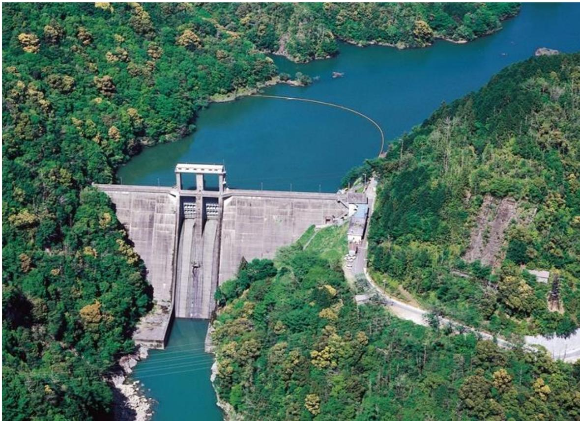
七川ダムは、常用洪水吐きに国内最古の高圧スルースゲートを設置した多目的重力式コンクリートダムで、戦後のダム史上極めて価値ある土木遺産です。
