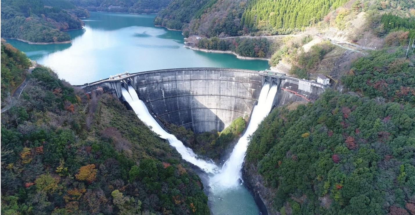
上椎葉ダムは、大調整能力を持つ水力発電用ダムとしては日本初の大規模アーチ式ダムで、戦後復興期に急増する九州の電力需要を支える上で大きな役割を果たした現役の土木構造物である。
