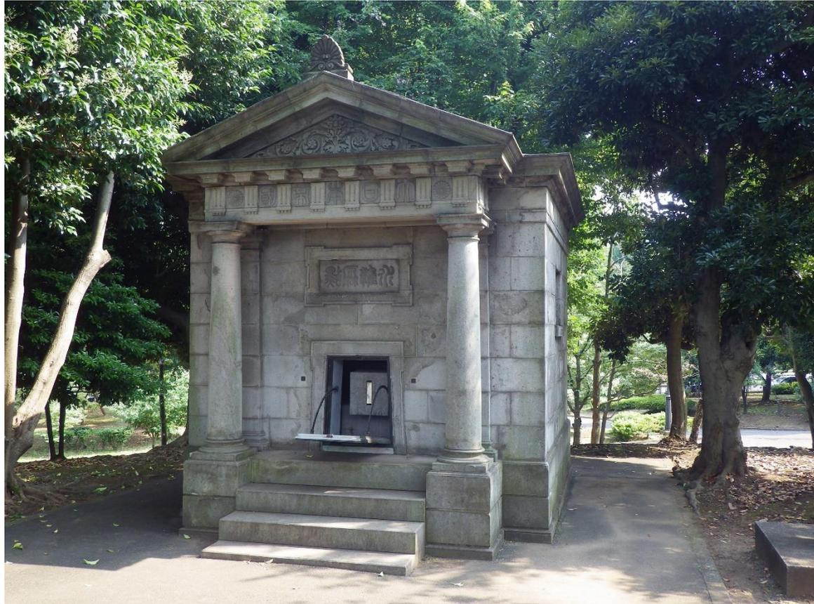
日本水準原点と日本水準原点標庫は、日本の高さ(標高)の基準として明治24年に陸地測量部により創設された原点標とそれを保護するための建築史上貴重な石造施設であります。
