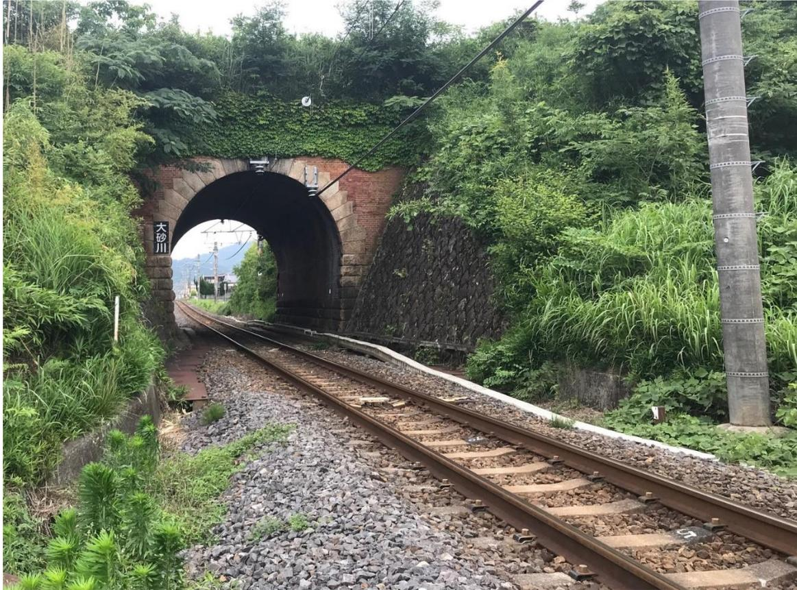
大砂川トンネルは、天井川である大砂川をくぐる石・煉瓦造の鉄道トンネルで、川越えの苦勞、明治の鉄道交通の近代化などを象徴する貴重な土木遺産です。
