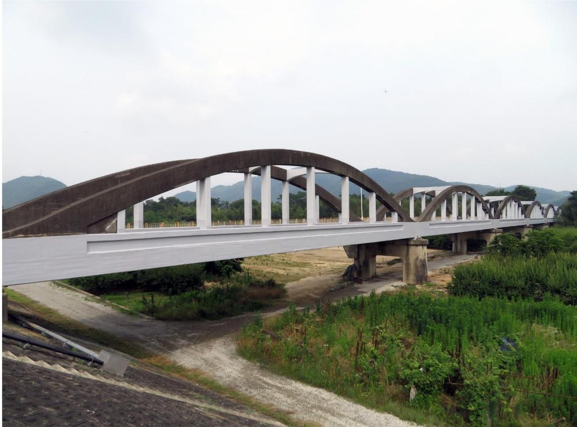
大原橋は、昭和9年の室戸台風の災害復旧橋梁として架橋された戦前最長のRCローゼ桁橋です。
