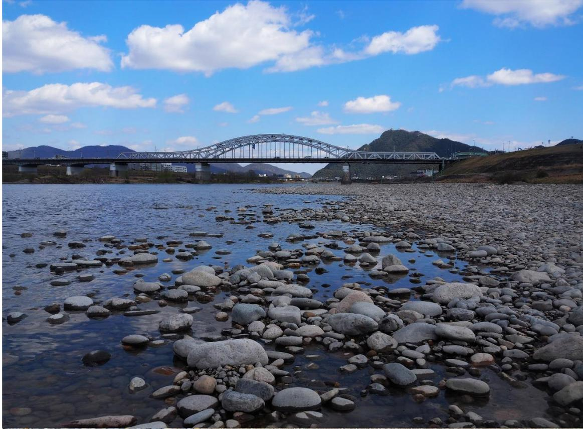
忠節橋は、岐阜市街地への重要なアクセス部に、河川大改修と戦争が終結するや否や建設された象徴的なブレーストリブバランストアーチ鋼橋です。
