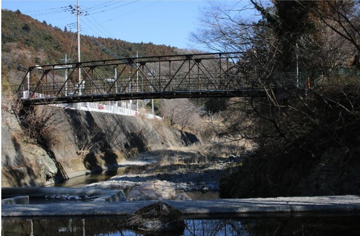
滝の鼻橋は、都幾川に架かる鋼製のワーレントラス橋梁であり、山型鋼をリベットで結合したトラスを用いている点が特徴の長さ21mの橋です。
