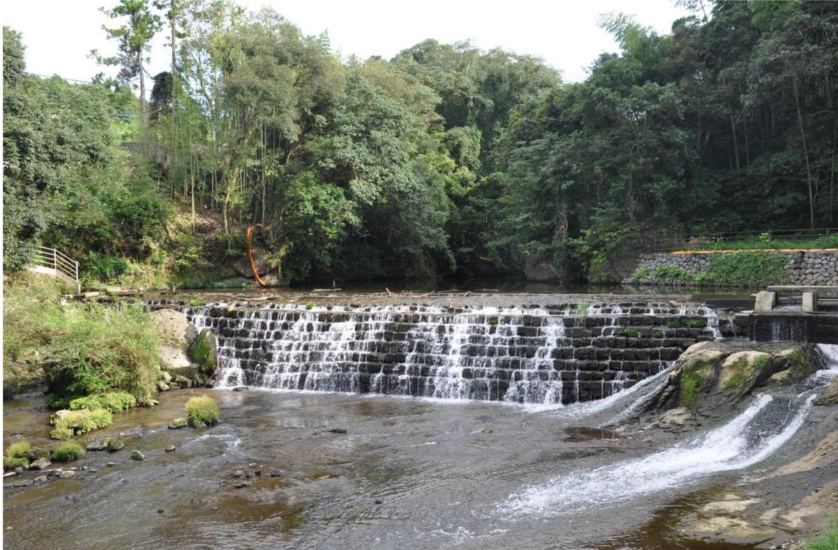
川畑井堰は宝暦年間に築造された幅18m、高さ3mを有する切り石による階段状の取水堰堤で、近世由来の取水堰堤としては全国で唯一と考えられる貴重な土木遺産である。
