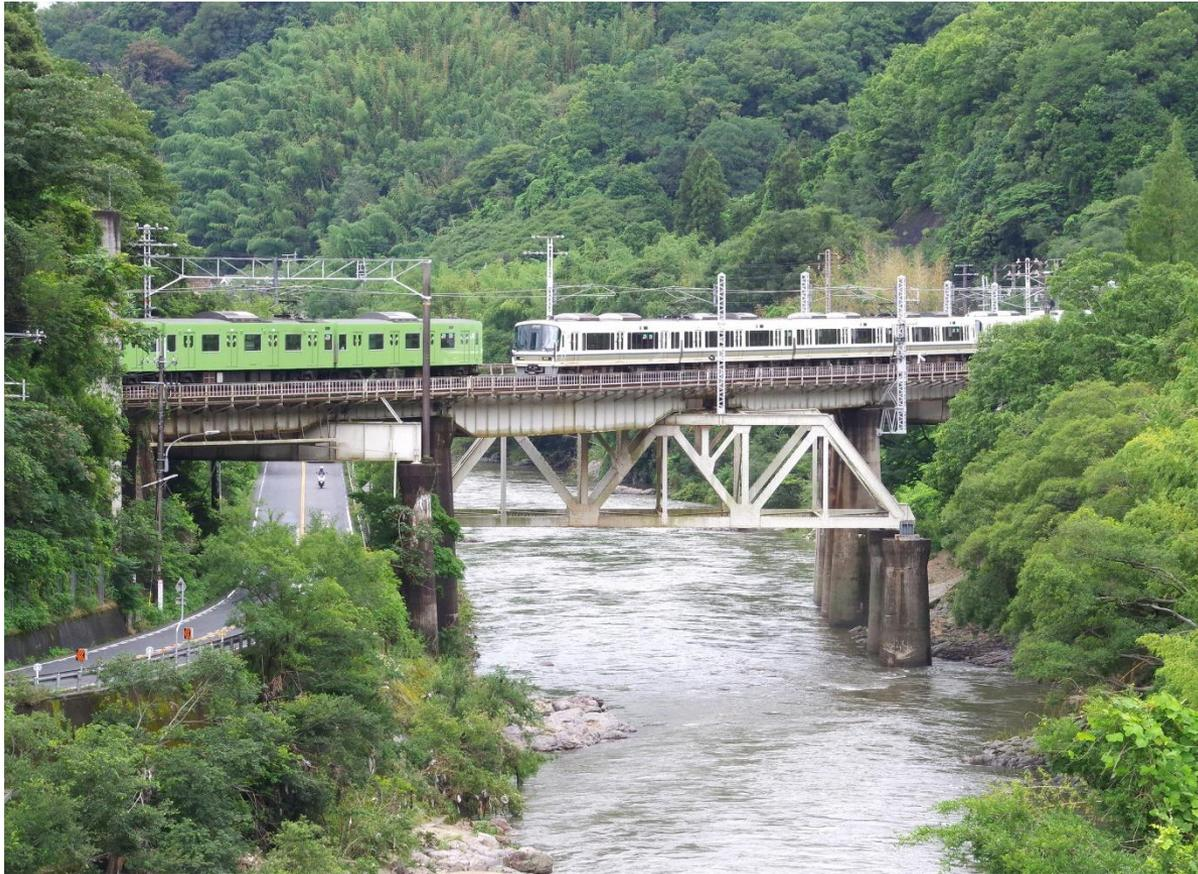
関西本線三郷～河内堅上間橋梁群を構成する第3大和川橋梁と第4大和川橋梁は、大規模な地すべり地を迂回するために特異な架構形態を採用した希少な鉄道構造物です。
