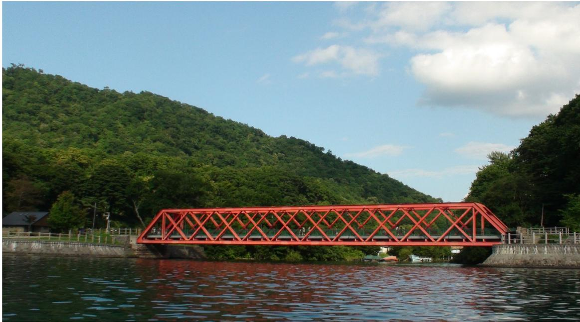
山線鉄橋は、千歳市支笏湖温泉地区の千歳川に移設された英国製の200フィートピン構造ダブルワーレントラス橋で、道内現存最古の明治期の鋼橋です。
