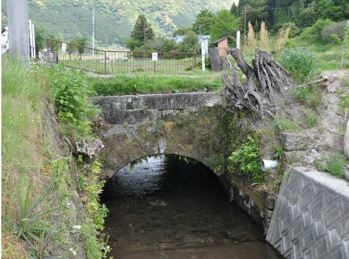
平熊の石洗越は農業用水路内への谷川の流入を防ぐために作られた石造構造物で、災害防御用としては全国で唯一の石アーチ橋です。
