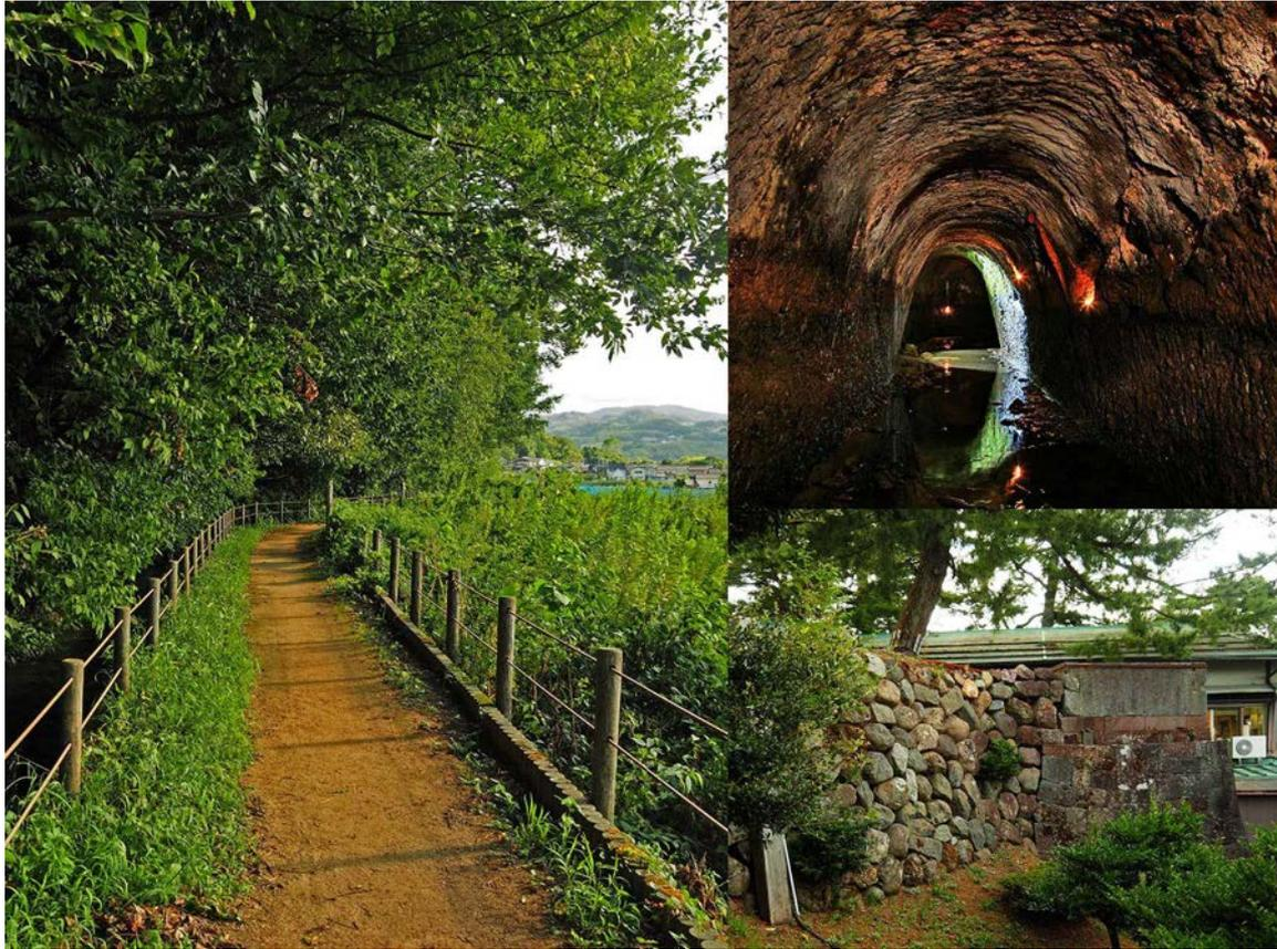
辰巳用水関連施設群は、小立野台地系を巧みに利用した隧道と開渠・暗渠によって金沢城内外を潤す水路と、横穴・管理道・伏越・専用水路などの関連施設群です。
