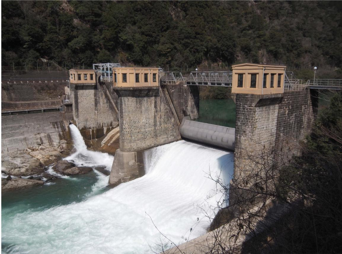
明上麻生発電所取水堰堤は、大正末期以降の濃尾の電力需要に対応して建設された、日本現存最古のローリングゲートの美しい発電用取水堰堤です。
