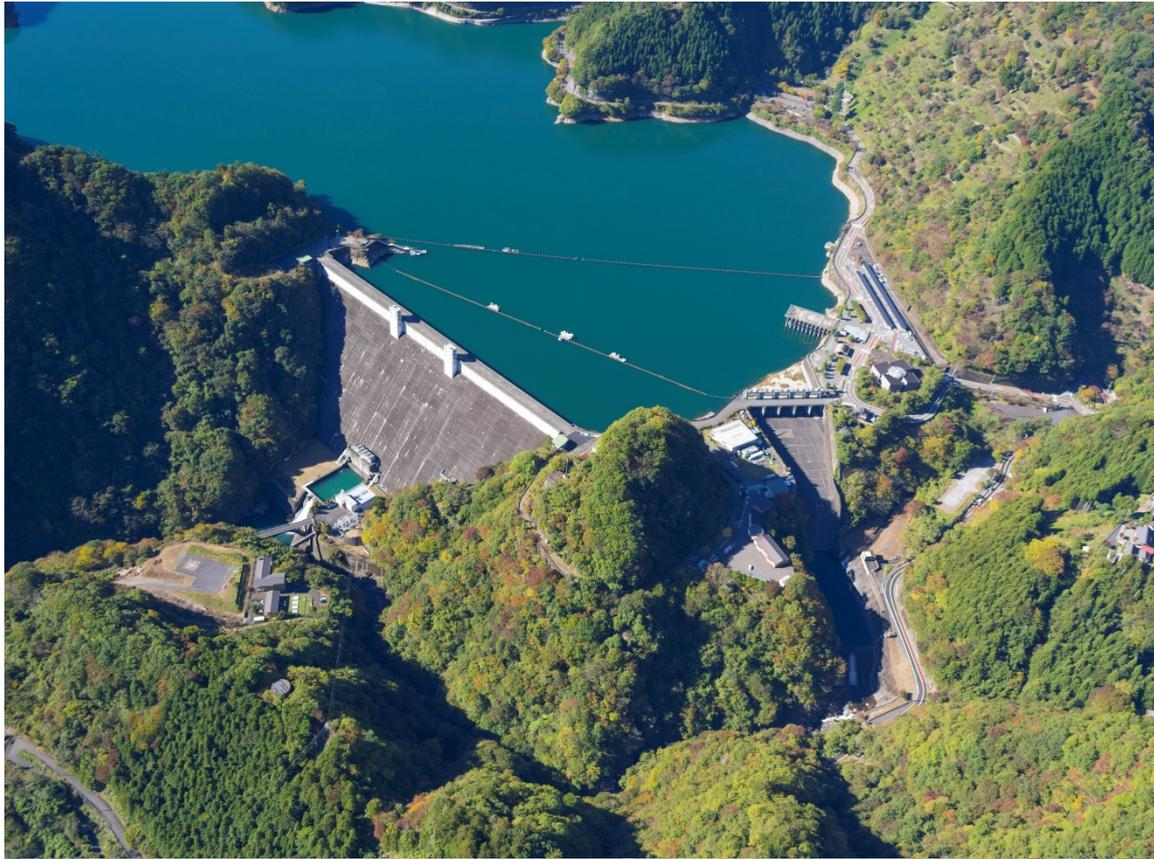
小河内ダムは、昭和32年に完成した貯水容量約1億8540万 $m^3$ を誇る国内最大の水道専用ダムであり、東京の安定給水を支える重要な土木遺産です。
