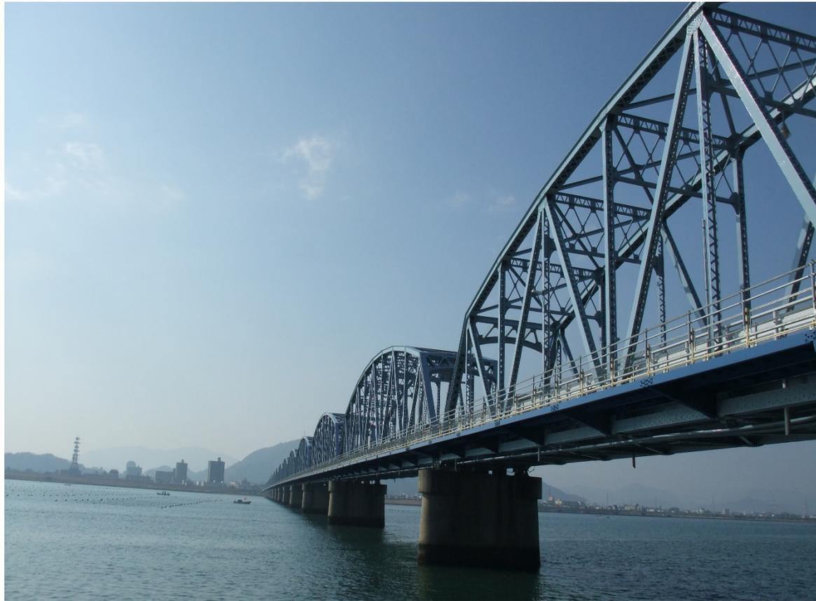
吉野川橋は、増田淳設計の吉野川に架かる橋長1070.2m、17径間の鋼ワーレントラス橋で、徳島県の発展の礎を支え、竣工当時の姿を残す貴重な橋梁です。
