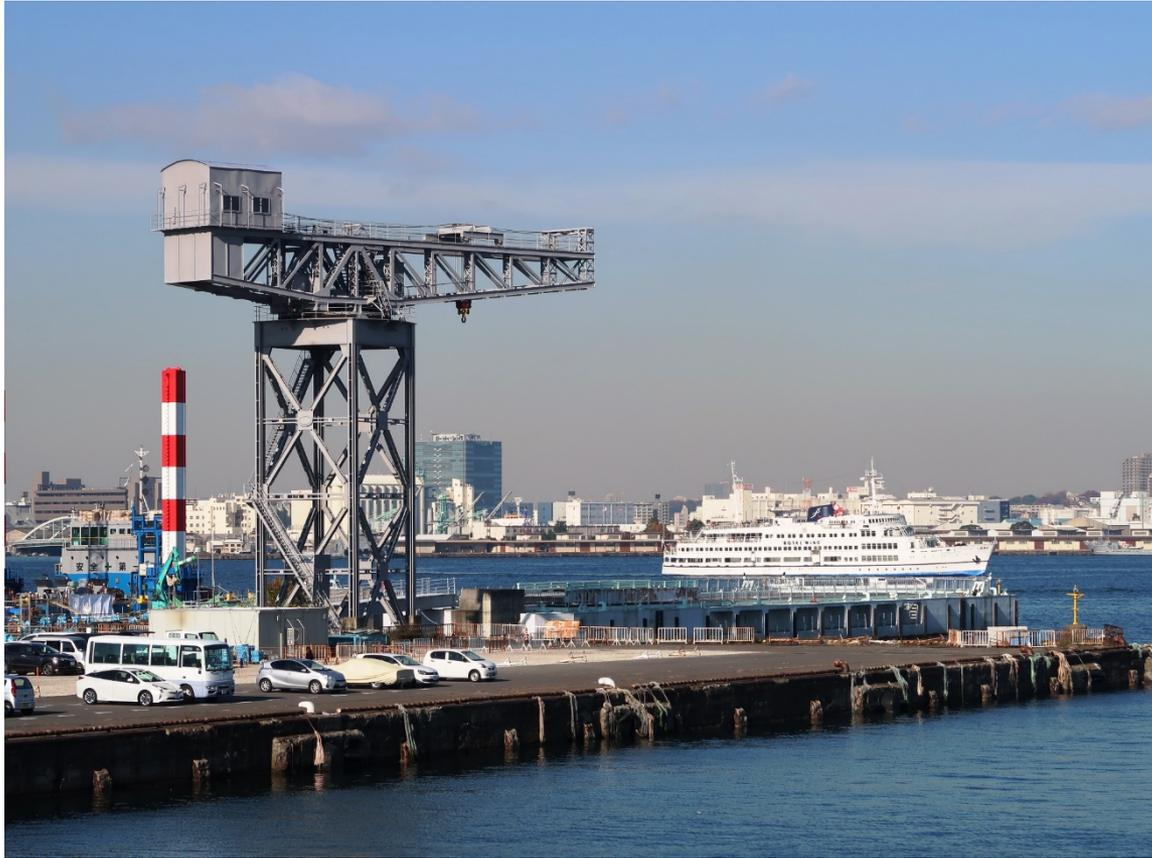
横浜港ハンマーヘッドクレーンは、我が国のクレーンによる荷役の先駆けとして堅固な基礎により建設以来百年以上も使用され、横浜港の基礎を築いた貴重な土木遺産であります。
