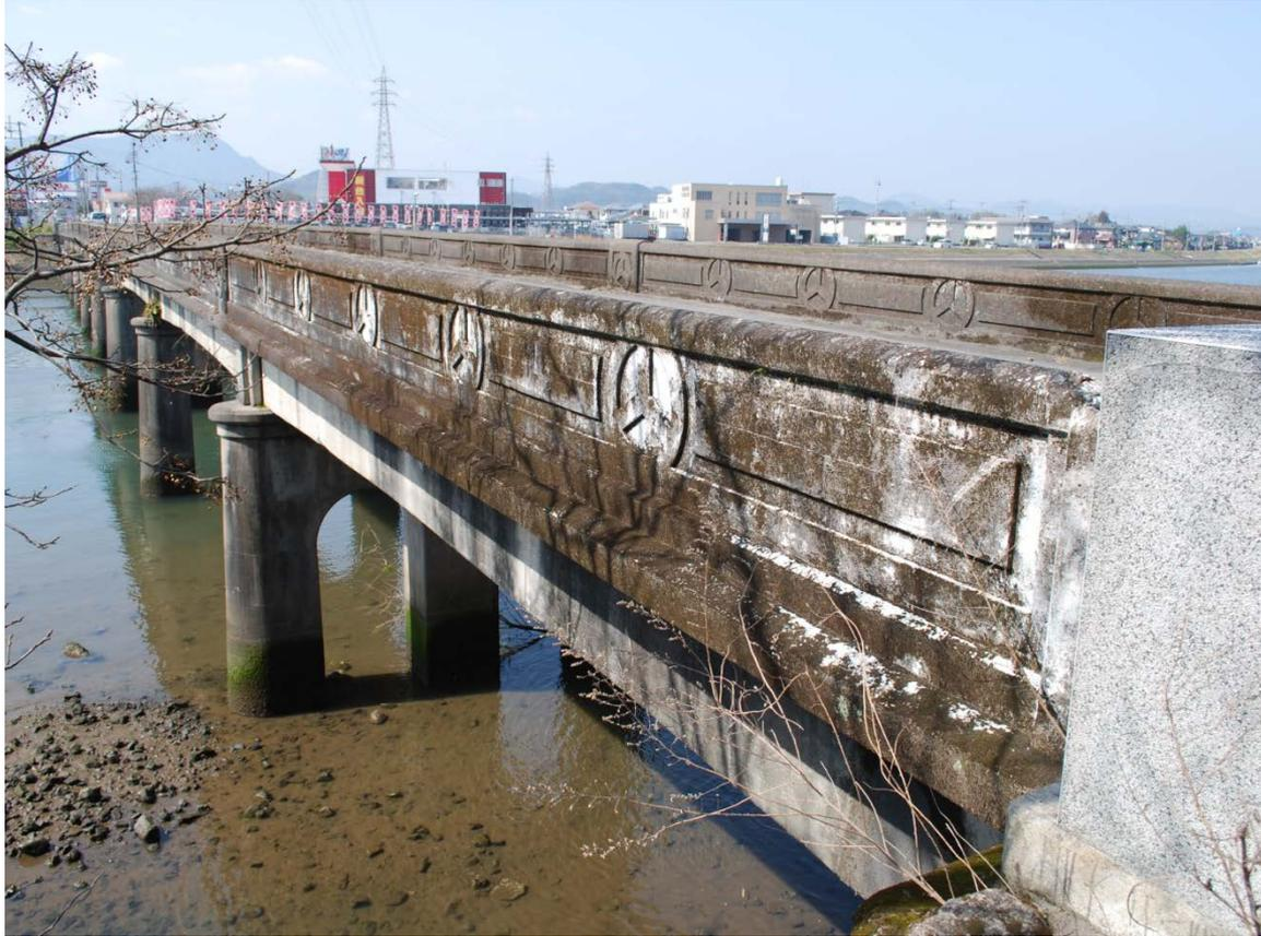
昭和初期に建設された橋長150mを超える鉄筋コンクリート桁橋であり、珍しい紋様の閉塞高欄を有する貴重な地域の土木遺産である。
