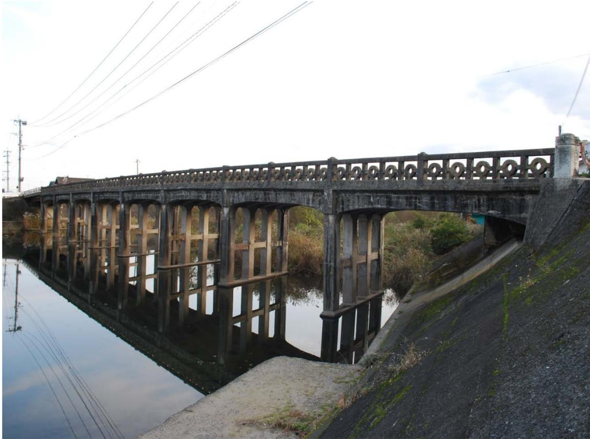
大正期に建設された初期の鉄筋コンクリート桁橋であり、本格的な井桁状の橋脚や円形模様の高欄を有する貴重な地域の土木遺産である。
