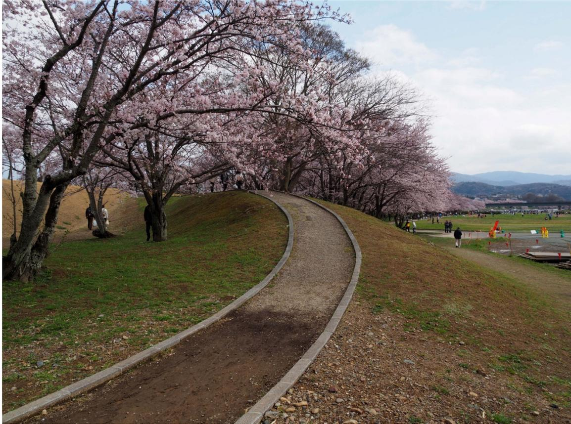
近世に伊勢の地を守るため築かれた宮川下流右岸の堤防で、本堤と刎出しと堤外植樹等で構成された現代にも治水上機能する土木遺産である。
