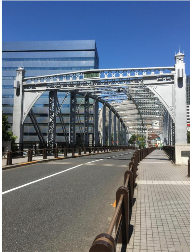
昭和7年に架けられた都内最古の鋼鉄トラスの道路橋であり、本体に明治時代の旧両国橋の一部が使用されている貴重な土木遺産である。
