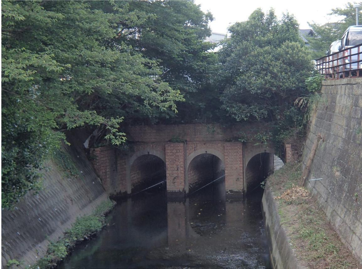
明治31年に建設された3連アーチの煉瓦造水門で、千葉県内で現存する煉瓦造水門の中で最も古く、歴史的価値のある構造物である。
