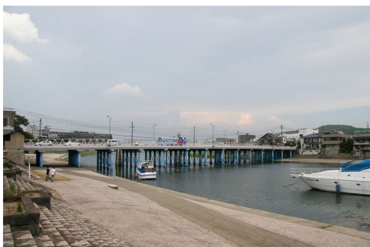
写真左：岡山市の旭川に架かる京橋全景
