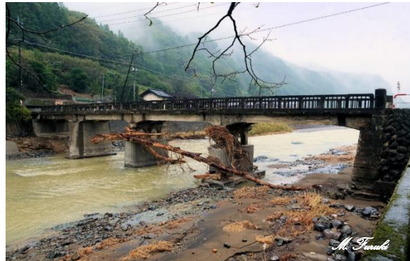
図表3 流木と橋梁 古い橋の例で、支間10m・4径間、流木の長さ20mであった。もし径間長が20あれば流木が掛かることもなく越水も避けられたであろう（群馬県鐺川森平橋 19.10.20 台風19号による出水直後に撮影）。
