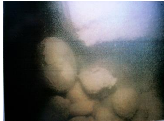
図4 写真上側に P8 のフーチングの角が映っている 3) 河床低下で捨石の下にあったフーチングが露出した。
