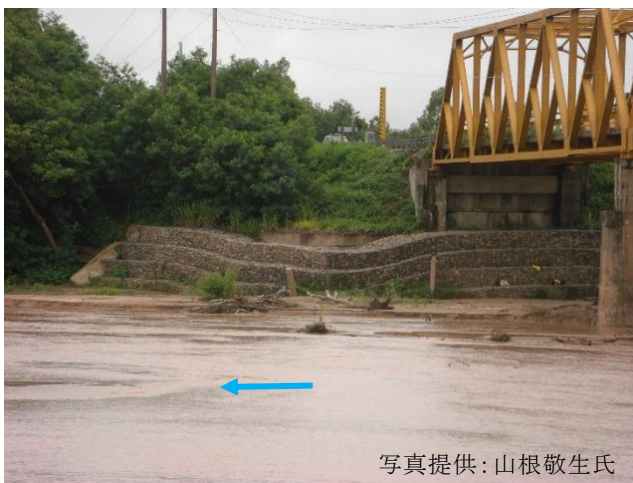
図 13 橋台の護岸に用いられた鉄線籠 橋台周りの護岸には鉄線籠が使用されている。地盤の変化にも柔軟に変形してその機能を維持している
