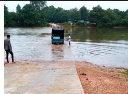
図 3 雨期の高水位で橋面が水没するときは、通行止めにするよう指導や表示をしているが、紅白の縁石が見える深さ 15 cm くらいまでは、利用者の判断で通行している。
