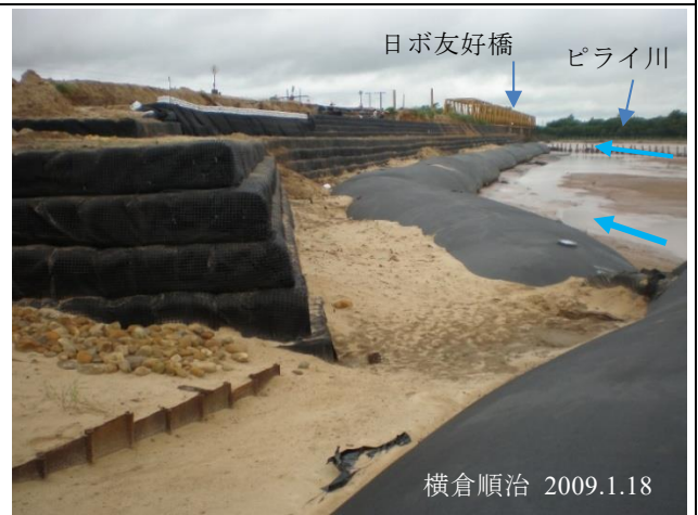
図 8 法面保護はソイルセメントを積めた土嚢、根固めは Geotube が使用されている。写真右下には Geotube 製の水制の一部が見える。
