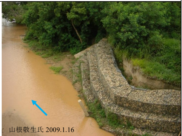
図 12 崩壊防止のために護岸盛り土に水平に埋め込まれているプラスチック製網材
