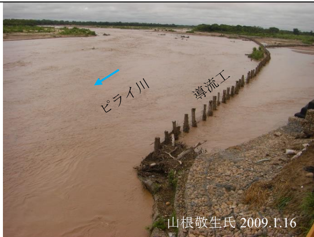
図 5 木杭・金網による導流工 導流工が河岸の固定に機能している。導流工は木杭・金網を利用した現地工法である。
