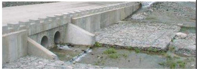
図 6 流量が多く、かつ土石流の流れる河川では連続ボックスカルバートを適用して、越流を許容する沈下橋となっている 2) 。
