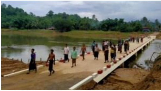
図 3 雨期の高水位で橋面が水没するときは、通行止めにするよう指導や表示をしているが、紅白の縁石が見える深さ 15 cm くらいまでは、利用者の判断で通行している。
