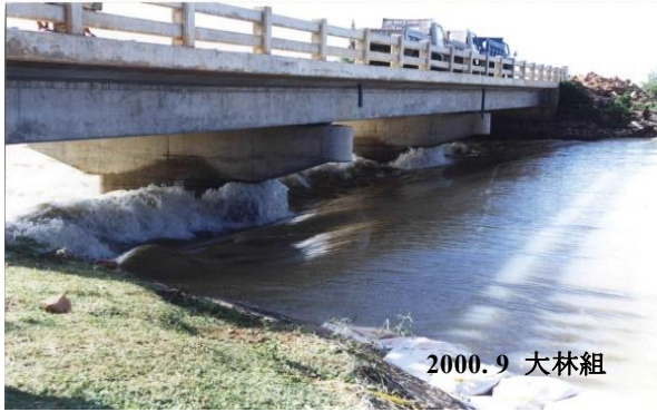
図 4 無償資金協力で新設された 6 号線の橋梁においては、2000 年洪水で道路盛り土の上下流で水位差が生じて射流と跳水が発生した。
