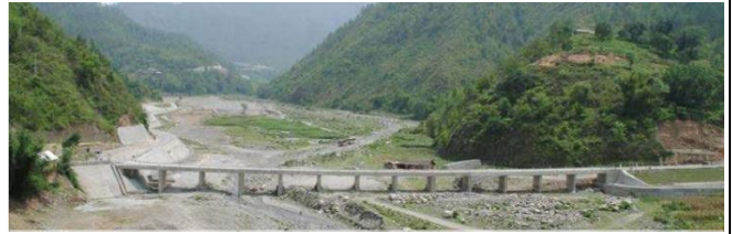
図 6 流量が多く、かつ土石流の流れる河川では連続ボックスカルバートを適用して、越流を許容する沈下橋となっている 2) 。
