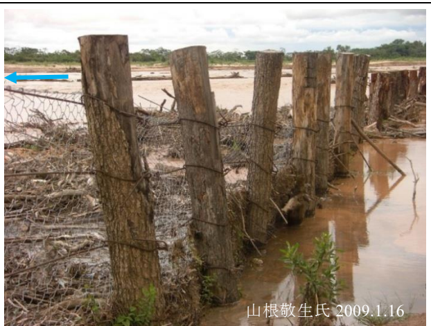
図 16 上流側でも水制により木の枝などの流下物が補足され、土砂堆積が促進されている
