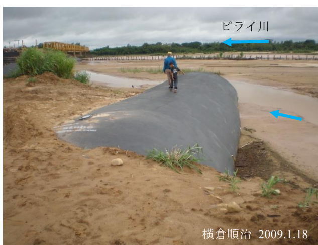
図 9 左写真の上流側に設置された Geotube 製の水制
