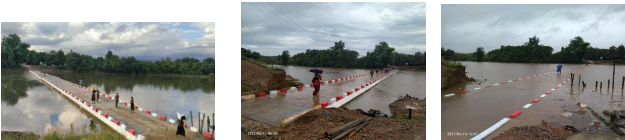
図 2 2020 年度の事業としてカイン州に建設された沈下橋
