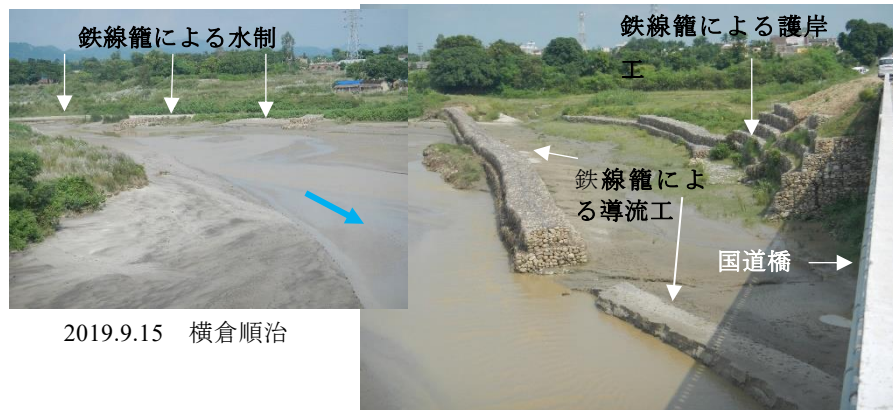
図 3 ネパールタライ平野 Kharak Khola 川で洪水流路に建設された取付け道路盛り土の浸食対策
