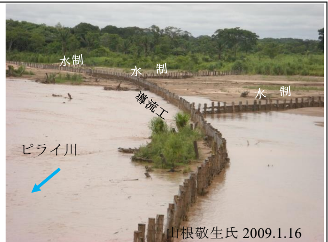
図 6 橋梁上流左岸では導流工と河岸から伸びた 3 条の水制が土砂堆積を促進している。
