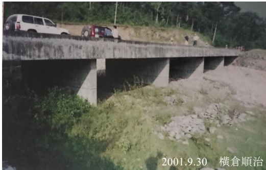
図 7 第 4 工区の橋梁は手すりがなく、越流を許容する構造（沈下橋）となっている。
