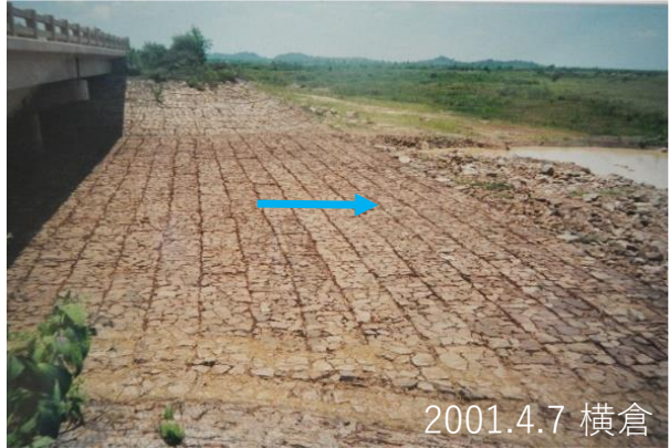
図 5 6 号線に新設された橋梁では、護床、護岸工洗堀に対して有効であり、かつ施工容易で廉価な鉄線籠が採用された。2000 年洪水で発生した左図のような射流・跳水によっても河床と盛土法面での洗堀は生じなかった。
