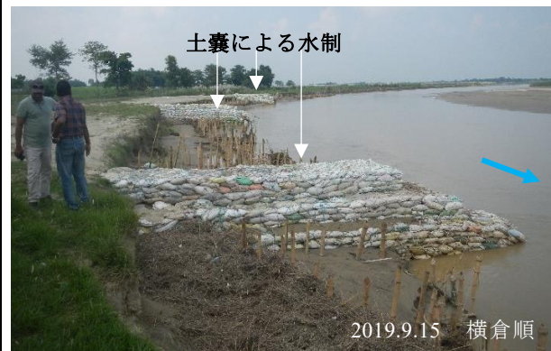
図 2 右図の水制は一基ごとに崩壊防止のために全体がネットで覆われている。
