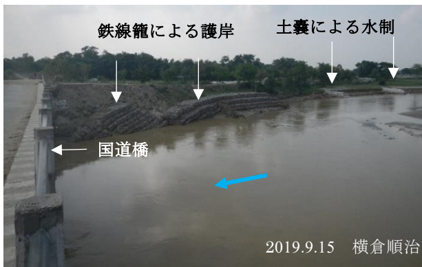
図 1 Lalbakaya 川右岸には、鉄線籠による護岸工と土嚢による水制が設置されている。
