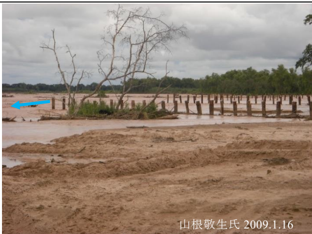
図 15 日ボ友好橋のさらに上流にも木杭・金網水制が設置されている（図 2 参照）。
