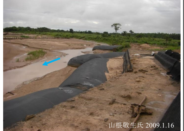
図 8 法面保護はソイルセメントを積めた土嚢、根固めは Geotube が使用されている。写真右下には Geotube 製の水制の一部が見える。
