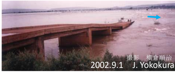
図 1 マリ ニジェール川で雨季に越流されている渡河施設(沈下橋 + 洗い越し)
