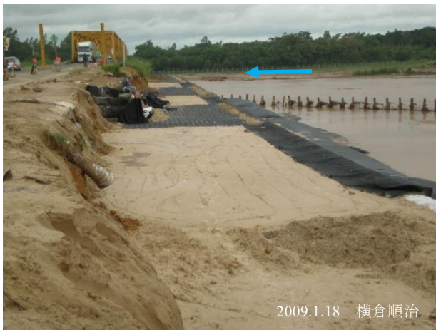
図 11 護岸法面の小段ごとに、プラスチック製網材を道路盛元法面まで、崩壊防止のために水平に埋め込んでいる。
