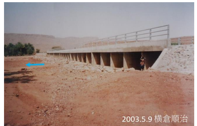
図 9 一時河川のコースウエー(7)下流側
