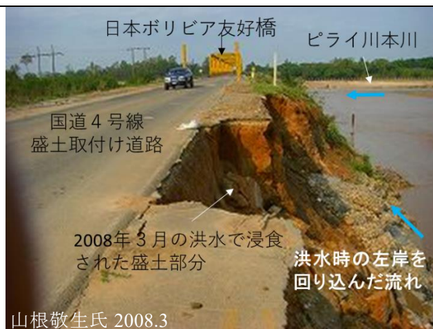
図 3 2008 年 3 月の洪水で左岸取り付け道路が浸食された。
