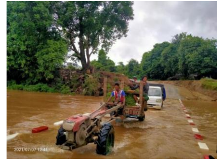
図 3 雨期の高水位で橋面が水没するときは、通行止めにするよう指導や表示をしているが、紅白の縁石が見える深さ 15 cm くらいまでは、利用者の判断で通行している。
