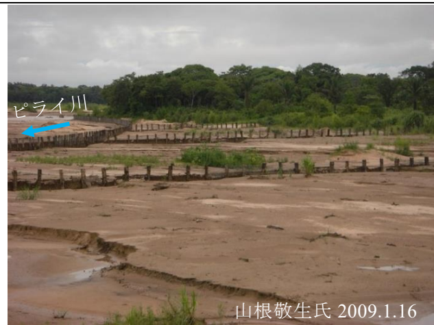
図 7 3 条の水制が土砂堆積を促進している。
