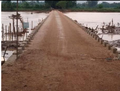
図 4 ミャンマー北部サガイン Region の沈下橋
