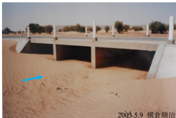
図 4 一時河川に建設されたコースウエー(3)
