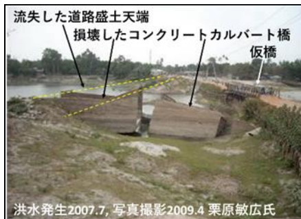
図 18 流失した道路盛土と崩壊したカルバート橋
