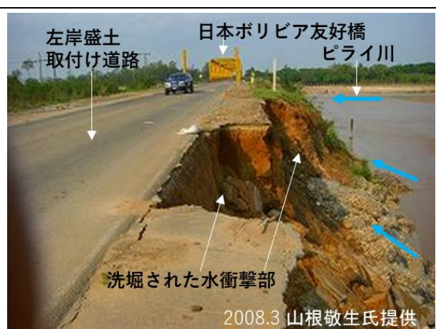
図 8 ボリビア国道 4 号線での 2008 年 3 月洪水で発生した取付け盛土の洗堀
