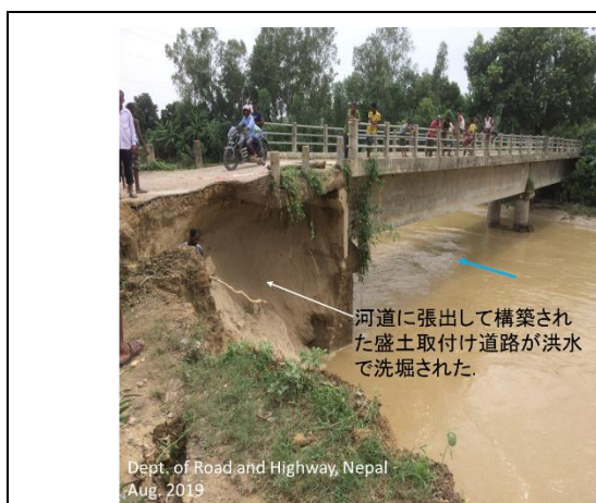
図 7 ネパールのタライ平野での 2019 年 7 月洪水で発生した取付け盛土の洗堀
