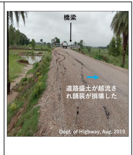
図 23 洪水の越流により損壊した道路舗装
