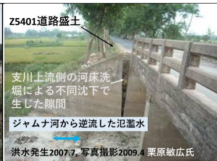
図 19 下流側河床洗掘で傾いたカルバート橋
