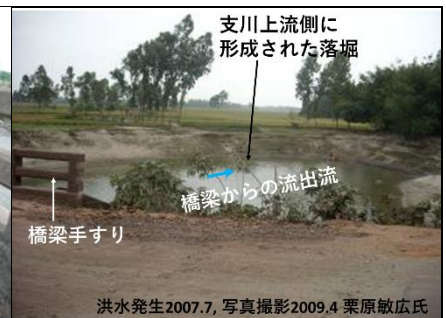
図 20 左図カルバートから流出した氾濫水により形成された落堀、深さは約 10m
