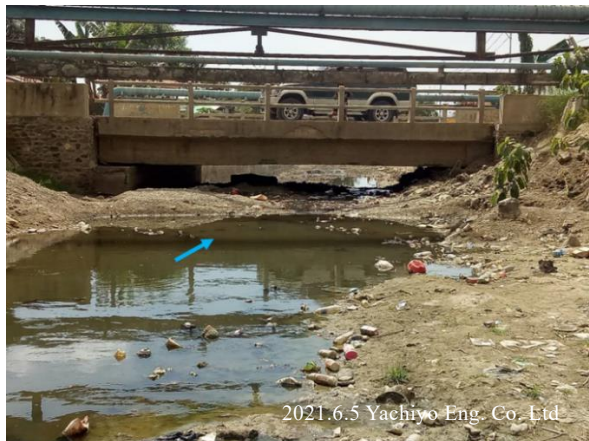
図 5 流積が不足しているマロア川の橋梁(図 2 橋梁 B)
