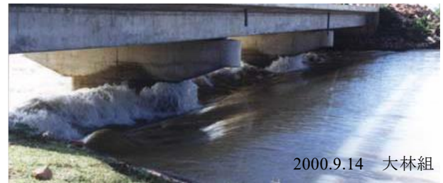
図 7 2000 年洪水時に日本の無償資金協力で新設された 6 号線橋梁で発生した水理現象（射流と跳水）
