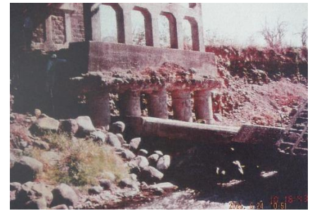
図 6 ヒボア橋東側 P11 橋脚基礎 洗堀され杭が露出した。 2)
