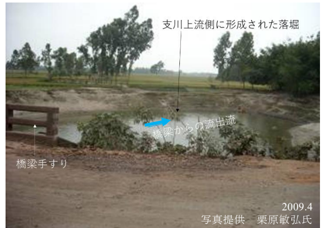
図 6 左図カルバートから流出した氾濫水により形成された落堀（深さは約 10m） 1)
