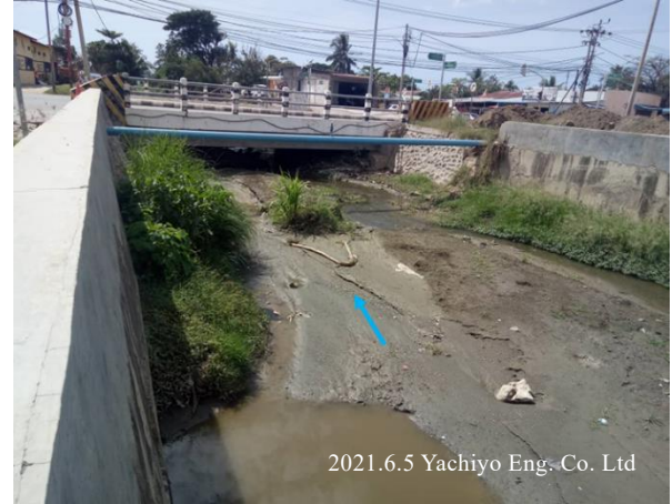
図 4 流積が不足しているマロア川の橋梁 (図 2 の橋梁 A), 上流側から
