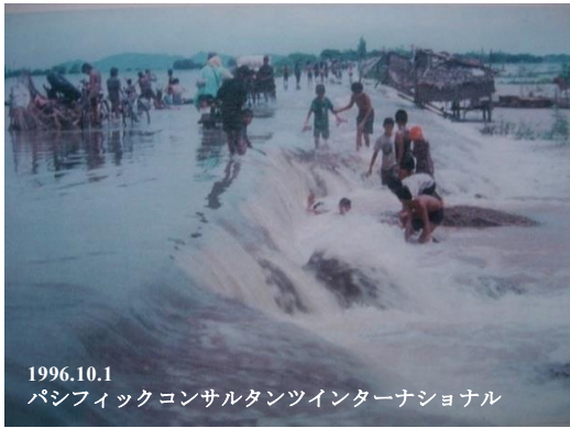
図 5 越流される 6A 号線盛土道路(6 号線交差点手前)
