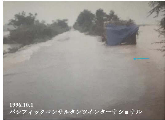
図 6 越流されている 6A 号線盛土道路
