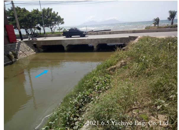
図 6 流積が不足しているマロア川の橋梁(橋梁 C)
