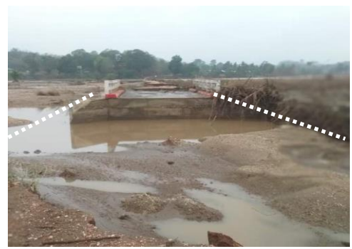
図 1 流失したアプローチ道路盛土
