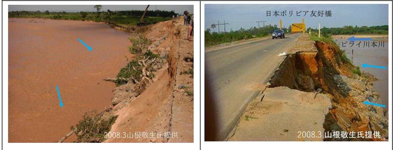
図 5 2008 年雨季末期での取付け盛土の上流側法面の浸食
