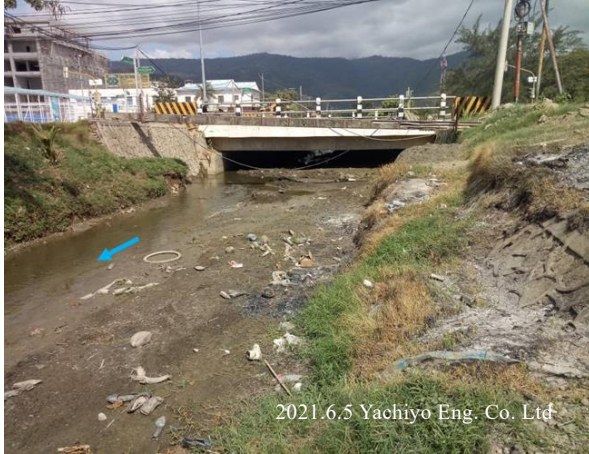
図 3 流積が不足しているマロア川の橋梁 (図 2 の橋梁 A), 下流側から
