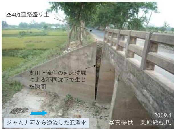
図 5 洗掘により傾いたカルバート
