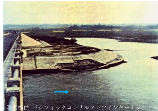
図 5 1991 年 10 月 19-20 日に発生した矢板護岸崩壊
