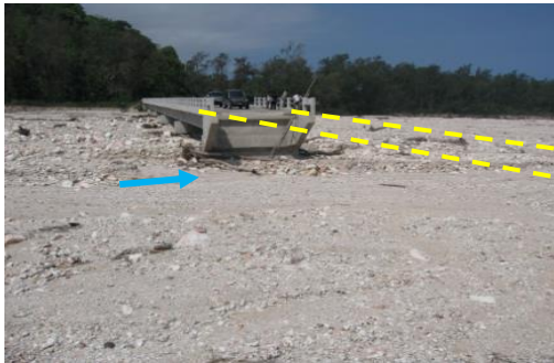
図 2 右岸側アプローチ盛土道路の流失状況
