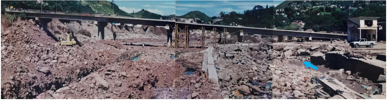
図 7 Chile 橋 1) 上流からの全景(橋長 134m, 6 径間)
