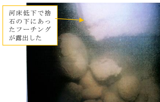
図 9 写真上側に P8 のフーチングの角が映っている 5)
