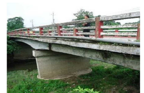
国道上のRC桁橋(2)
