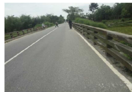
国道上のRC桁橋(1)
