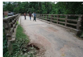
地方道上のRC桁橋
