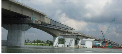
ゴムティ橋での送出し状況
